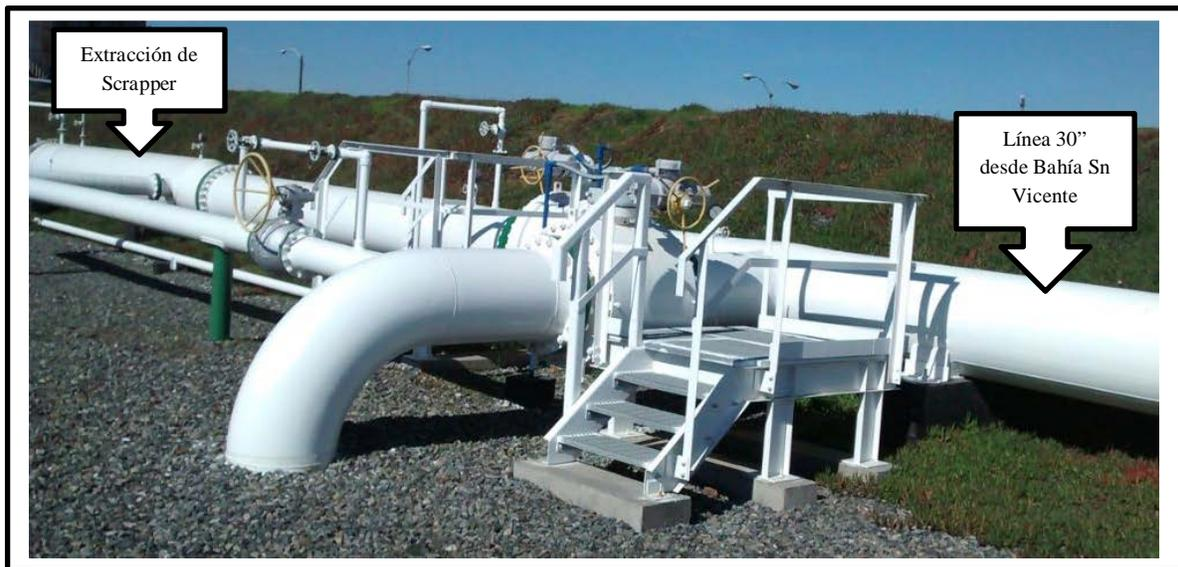
Figura N° 3: "Área de Extracción del Scrapper"
