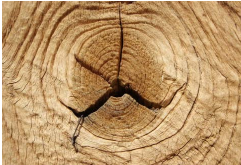
Figura 6. Rollizo de Madera Agrietado
