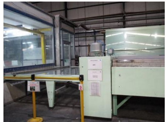
Figura 28. Zona de sellado
