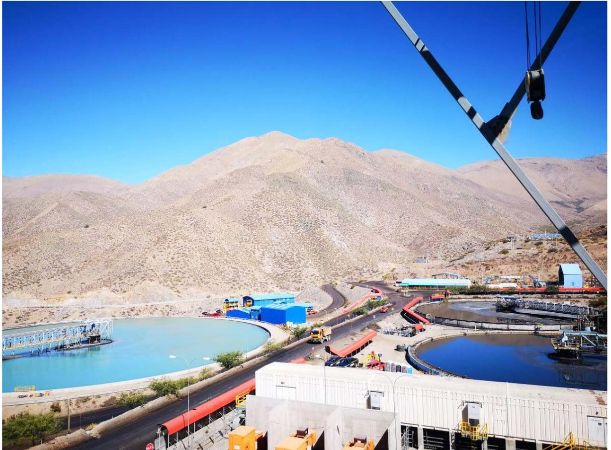
*Figura 50. Espesadores planta concentradora.*
