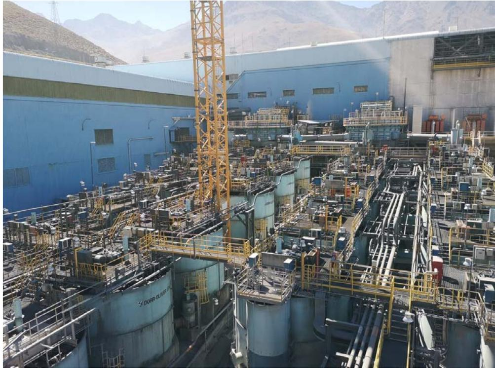
*Figura 45. Celdas de flotación exteriores MLP.*
