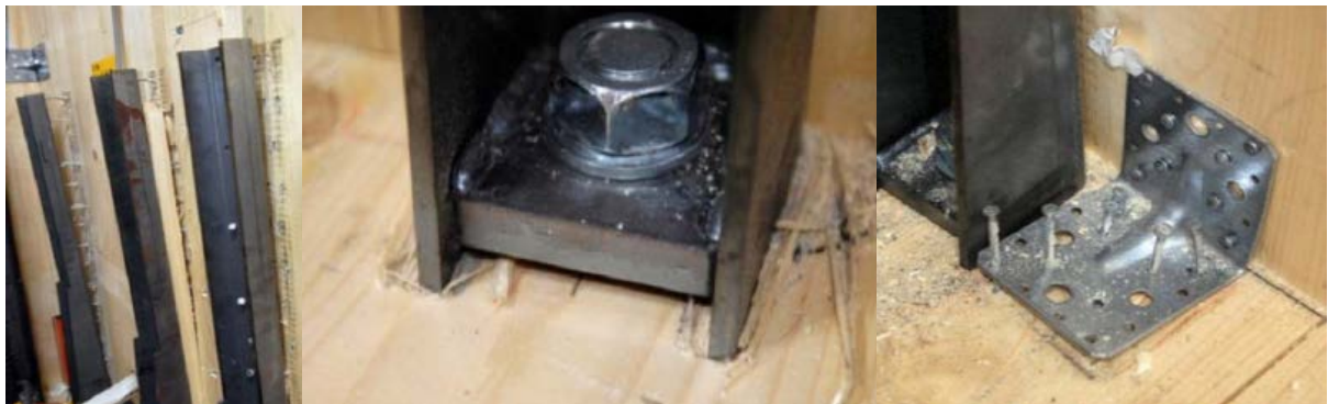
Figura 24: Daños durante ensayo a escala real (Ceccotti et al. 2013)
