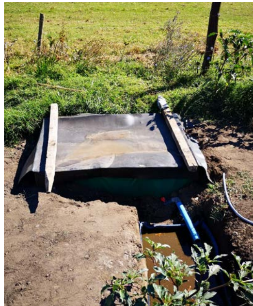
Figura 12: En la figura encontramos el sedimentador en funcionamiento, y se puede apreciar material ya extraído en la parte inferior (Fuente Propia).
