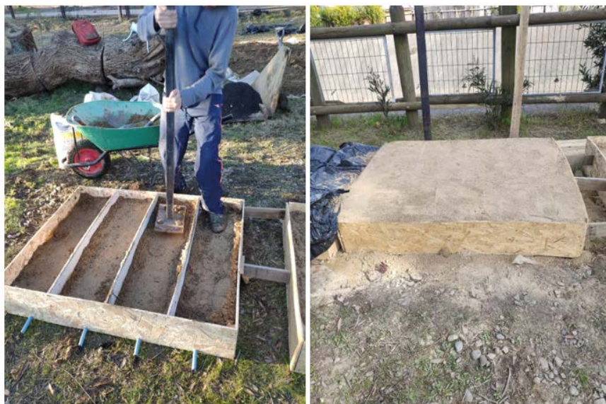
Figura 13: Compactación con pisón
