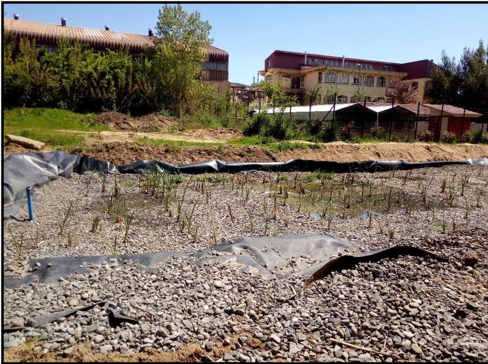
**Figura 25. Perfilado del talud para definición de pendientes. (Fuente propia)**
