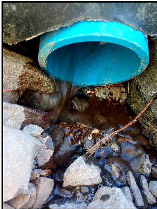
**Figura 36. Flujo ingresante en el sistema de drenaje. (Fuente propia)**
