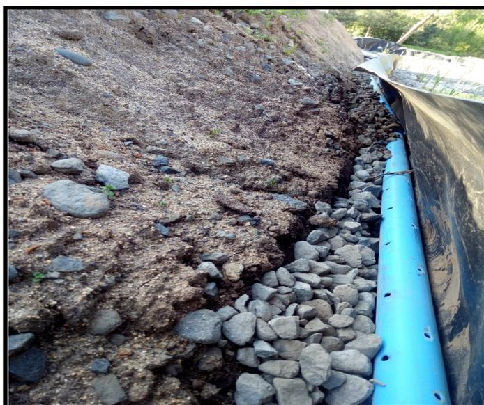
**Figura 31. Instalación del sistema de drenaje. (Fuente propia)**
