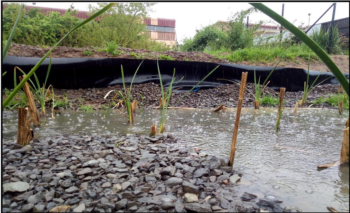
**Figura 32. Salida del drenaje hacia el humedal utilizando una unión T. (Fuente propia)**
