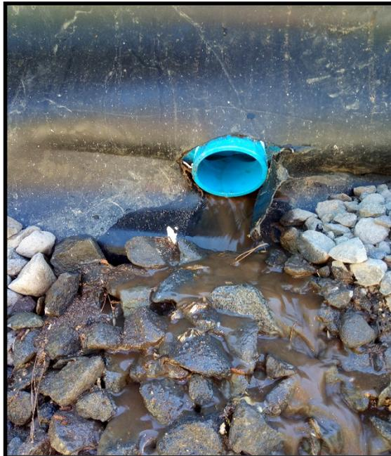
**Figura 35. Flujo de agua que drena bajo la tubería. (Fuente propia)**
