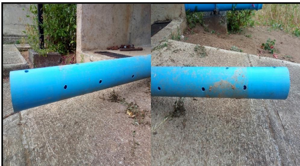
Figura 29. Preparación de perforaciones en tubos del dren. (Fuente propia)
