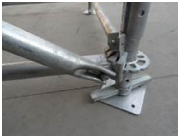
Figura 5. Fotografía vista de la diagonal conectada a las fijaciones del pie derecho
