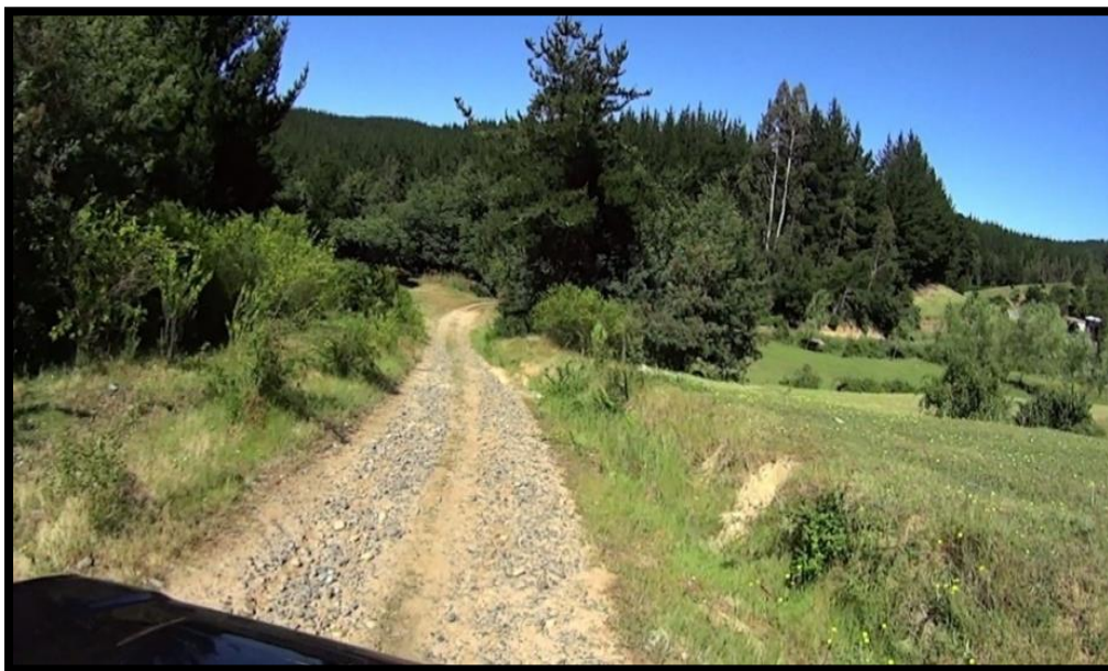
Figura A3: Estado del Camino Tramo final, Zona Baja
