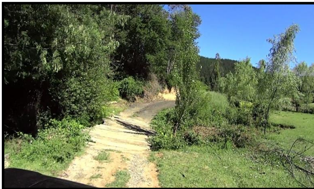
Figura A5: Puente de Madera que Cruza Cauce Natural
