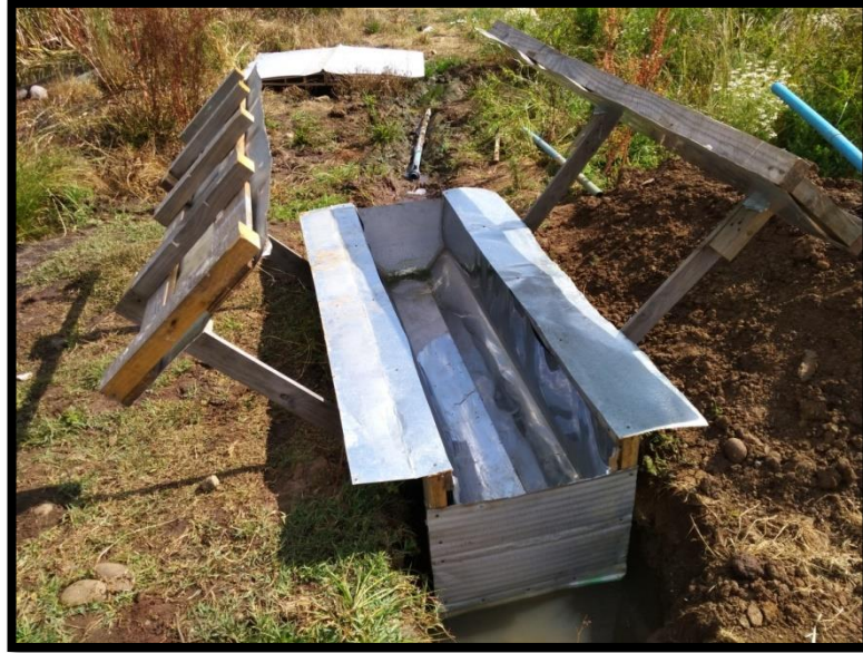
Figura B3: Instalación paneles y aletas reflectantes.
