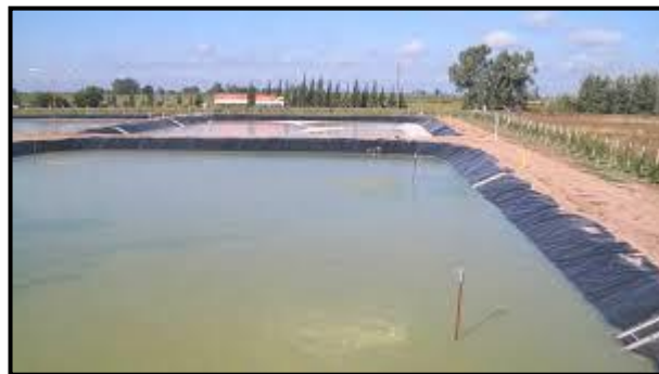
Figura 3: Lagunas de maduración.
