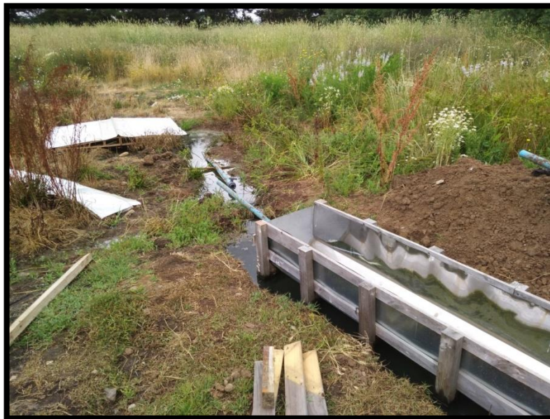
Figura B2: Instalación del canal a la salida del Humedal Artificial.
