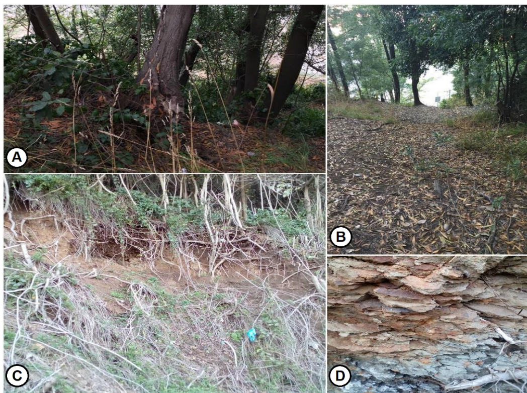
Figura 3: a) Árbol caído recientemente. b) Material superior con materia orgánica y pendiente variable. c) Escarpe hacia la corona del talud. d) Fragmentación frágil del material cementado.
