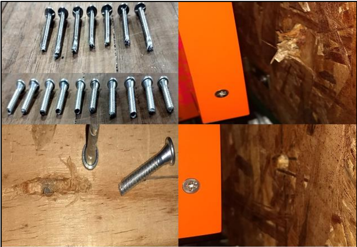
Figura 15 Falla típica de los materiales utilizados
