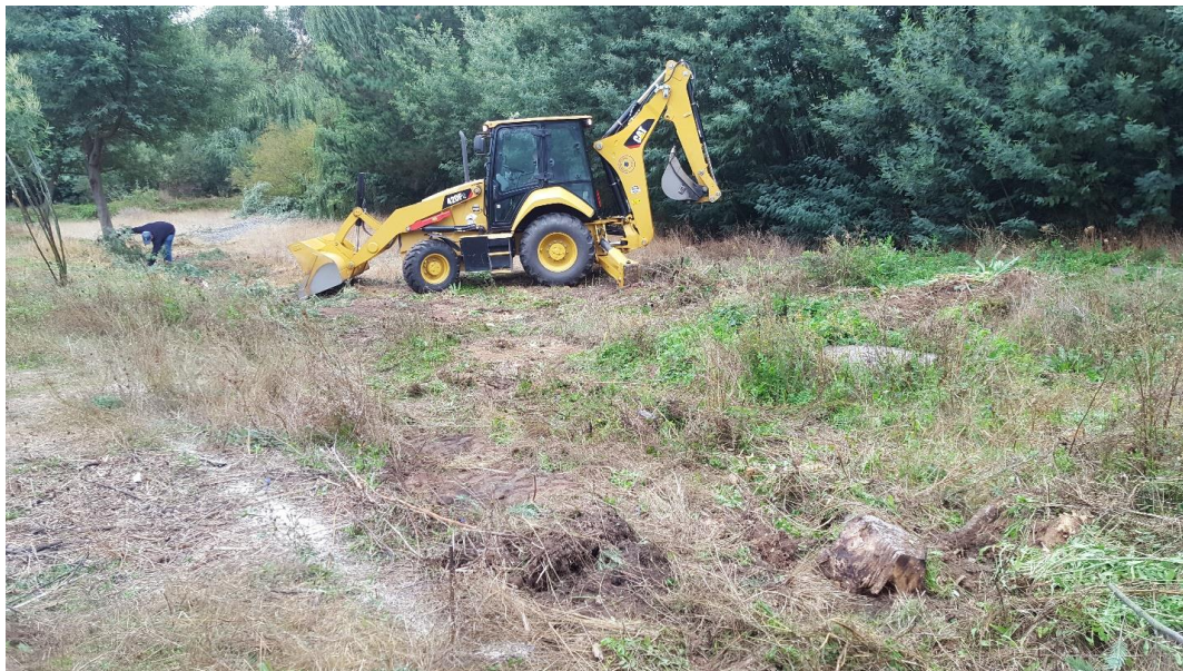
Figura 22: Limpieza de terreno.
