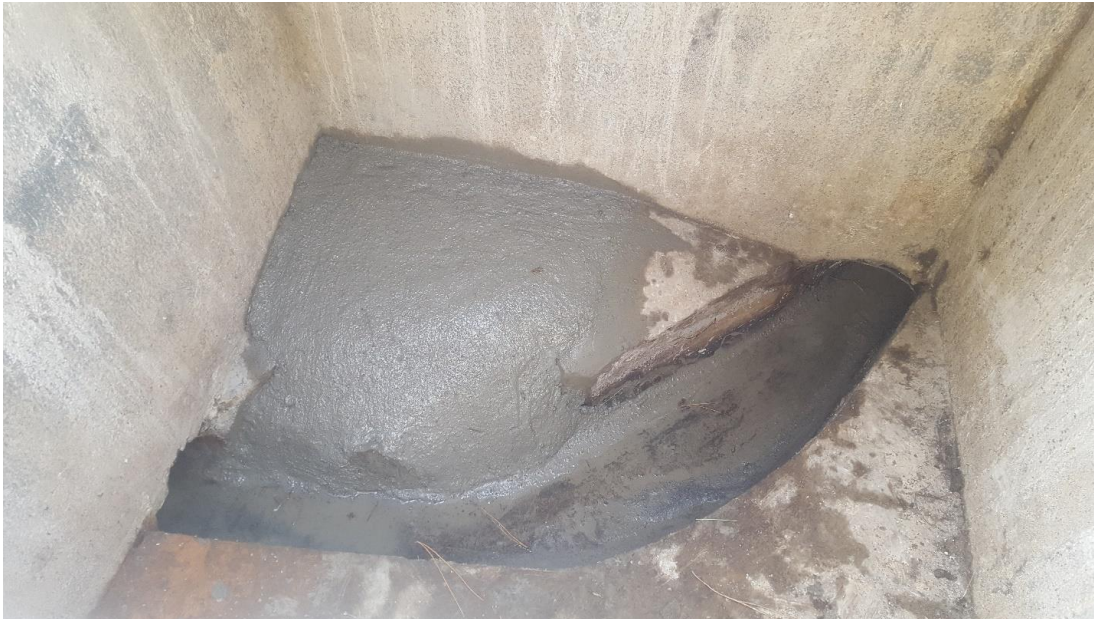
Figura 21: Sellado de cámara existente.
