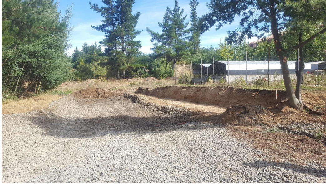
Figura 23: Excavación de terreno.
