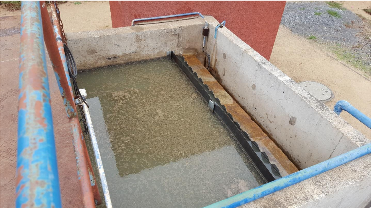
Figura 6: Sedimentador secundario.
