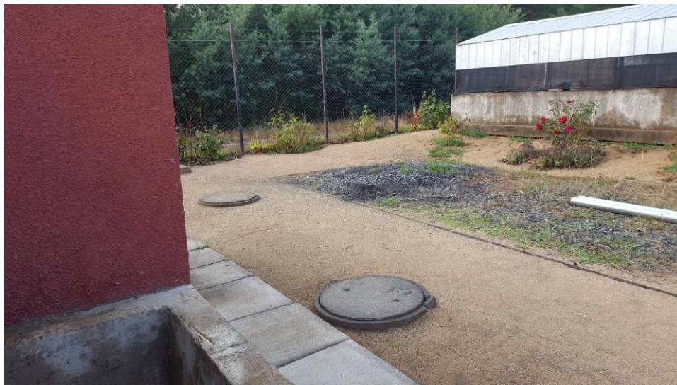
Figura 13: Cámara existente. Fuente: Elaboración propia.
