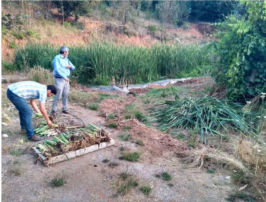
Figura 28: Extracción de espadañas.
