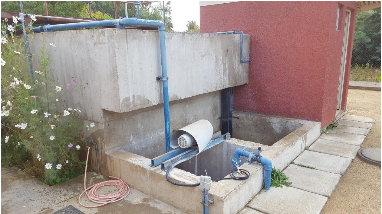
Figura 8: Estanque estabilizador.
