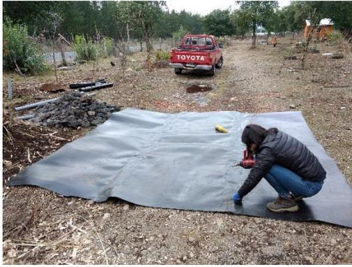
Pegado de la lámina impermeabilizante de HDPE 1.5mm
