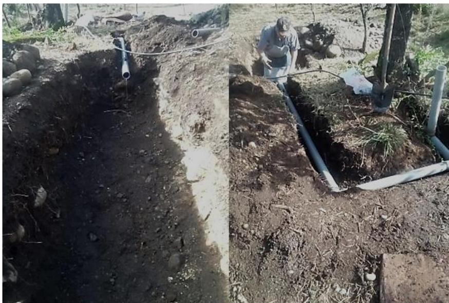
*Figura 16: Construcción y unión con fosa séptica.*
