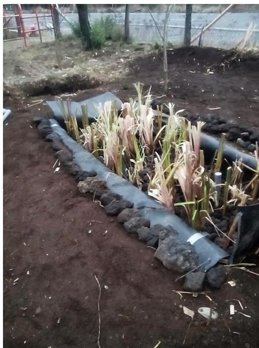
Figura 21: Instalación de plantas y construcción de humedal finalizada.
