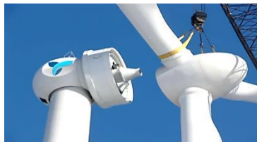
Figura 32 – Instalación del buje en el eje.
