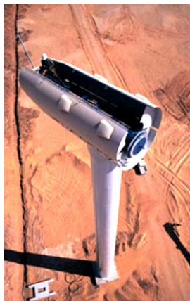
Figura 31 – Montaje de góndola de un aerogenerador.
