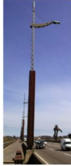
Figura 70 – Poste del puente Llacolén.
