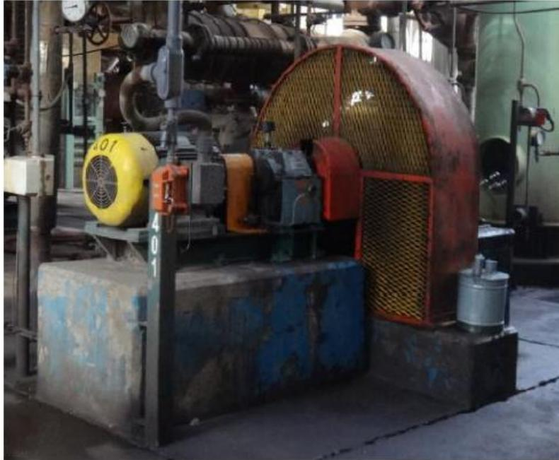
FIGURA 4-12. Fotografía compresor recíproco J-401. (Fuente: ENAP Refinerías Bío Bío).
