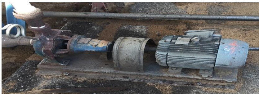
Figura 3.13: Bomba Vogt H 625 (Fuente:Elaboración propia)
