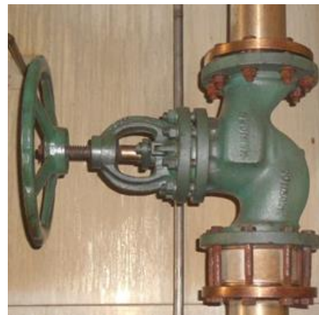
Figura 3.3: Válvula de pistón Klinger (Fuente: Propia)
