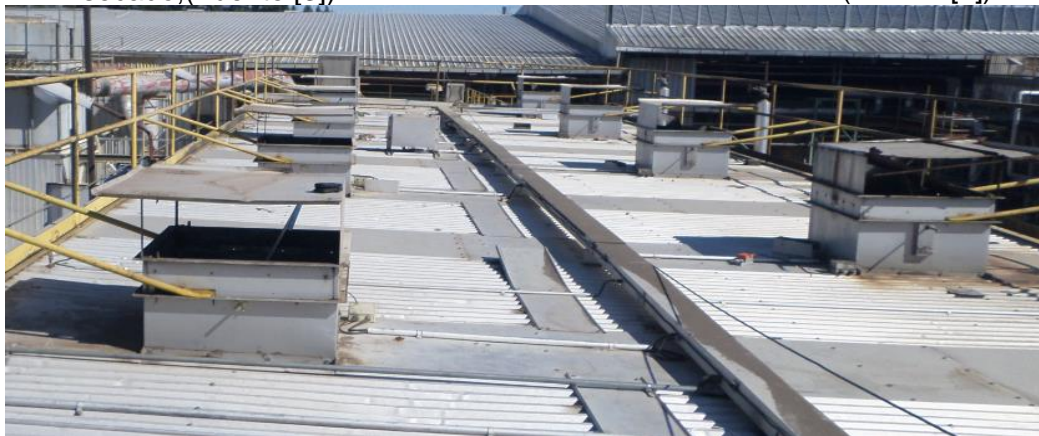
Figura 3.12:Ventilas en cámaras de secado(Fuente:[3])
