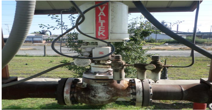
Figura 3.4: Válvula reguladora de presión (Fuente: elaboración propia)
