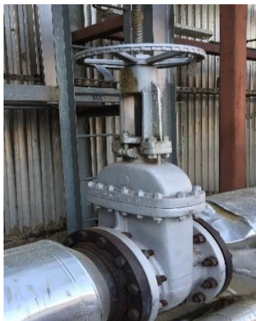
Figura 3.2: Válvula de compuerta (Fuente: Propia)
