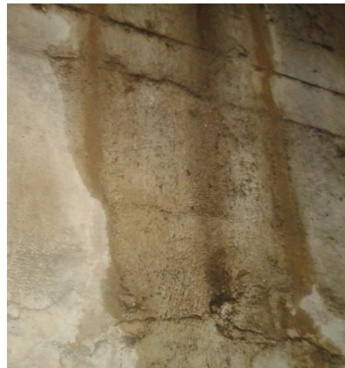
Figura 3.15 Paredes del recinto Fuente: Instalación de la planta
