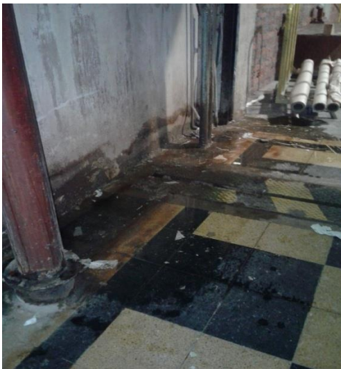
Figura 3.14 Zona lateral acceso bobinadora Fuente: Instalación de la planta
