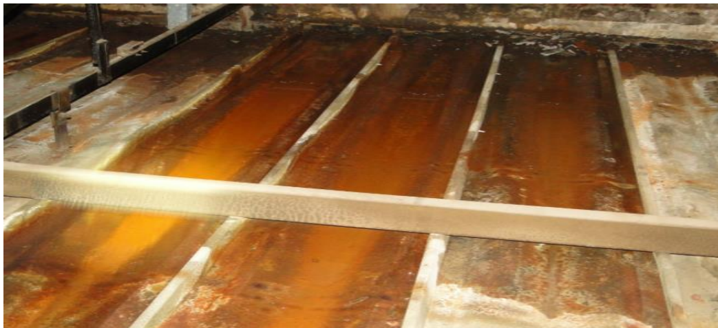
Figura 3.30 Sector sobre la entrada de MP-2 Fuente: Instalación de la planta
