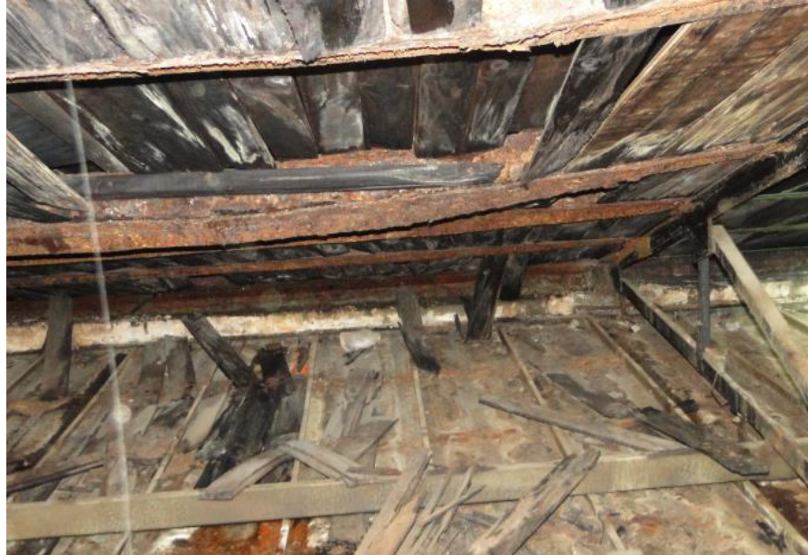
Figura 3.27 Estado del techo y vigas Fuente: Instalación de la planta
