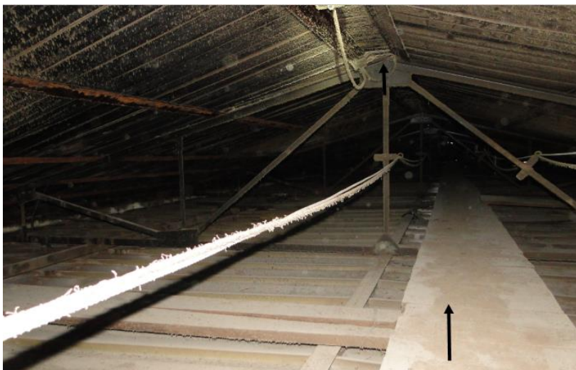
Figura 3.25 Entretecho o ático del recinto Fuente: Instalación de la planta
