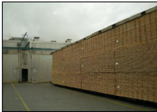
Figura 1.1 Cámara de secado de Alta Temperatura. (Fuente: Becerra 2010).
