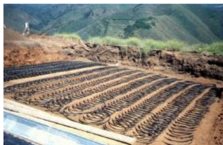
Figura 3.7: Intercambiador de tubo en espiral de lazo cerrado.
