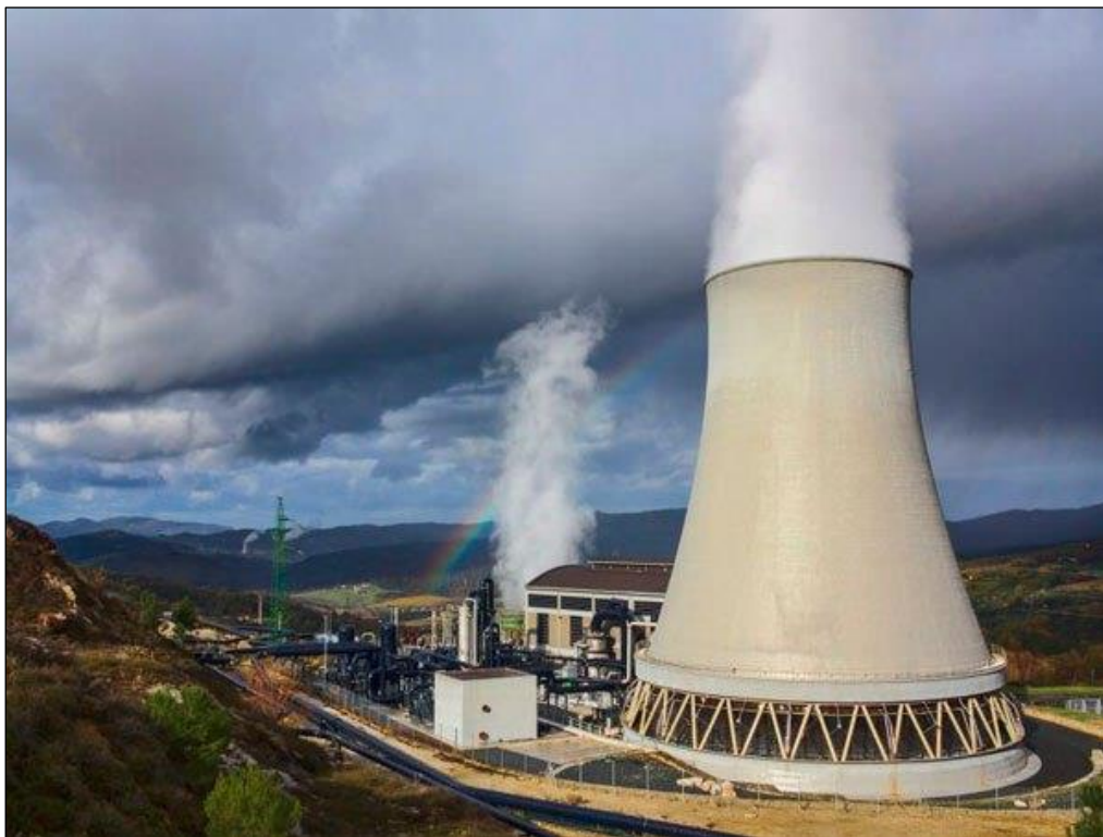
Fotografía 4.2 Torre de enfriamiento del complejo geotérmico Larderello. [65]
