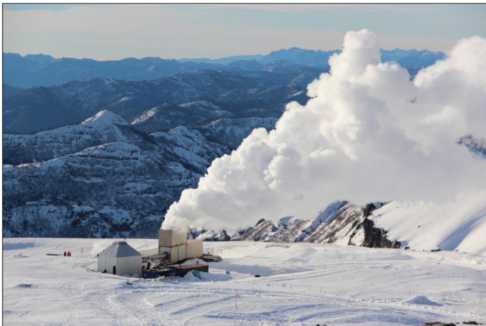
Fotografía 5.8. Pozo de Producción de la central Geotérmica Curacautín. [14]
