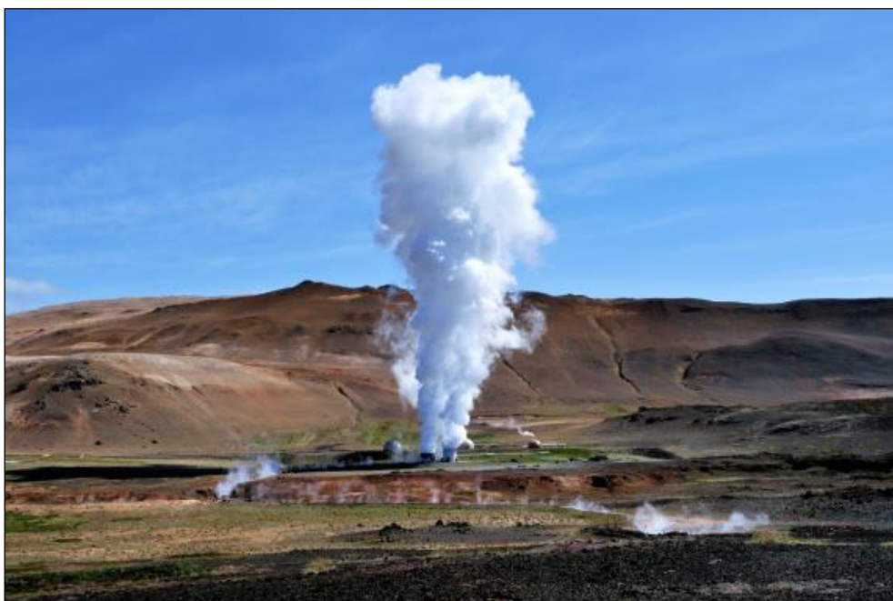
Fotografía 5.7 Pozo de Producción de la central Geotérmica Cerro Pabellón. [44]
