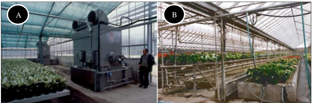
Fotografía 2.2 Dos modalidades de calefacción de invernaderos. [9]
