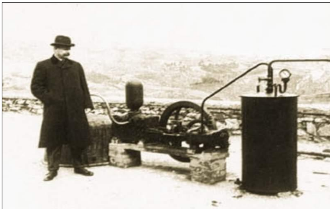
Fotografía 5.1 Primera central geotérmica del mundo. [57]
