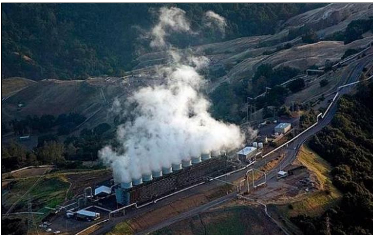
Fotografía 5.2 Complejo geotérmico The Geysers, EEUU. [65]
