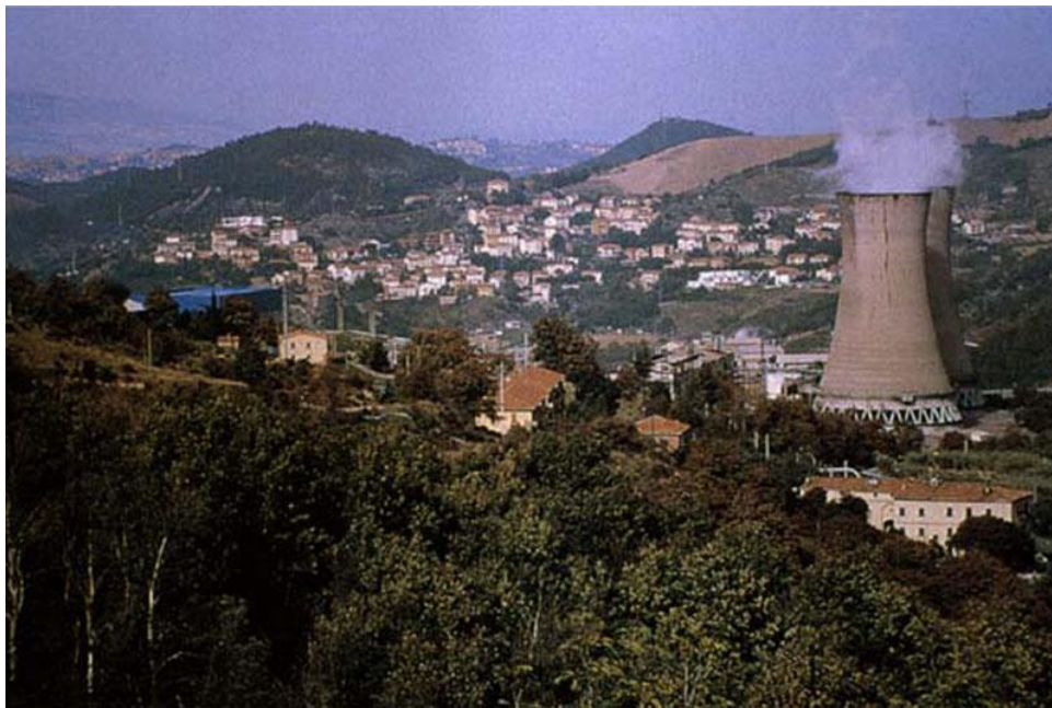
Figura 1.7: Torres de enfriamiento
