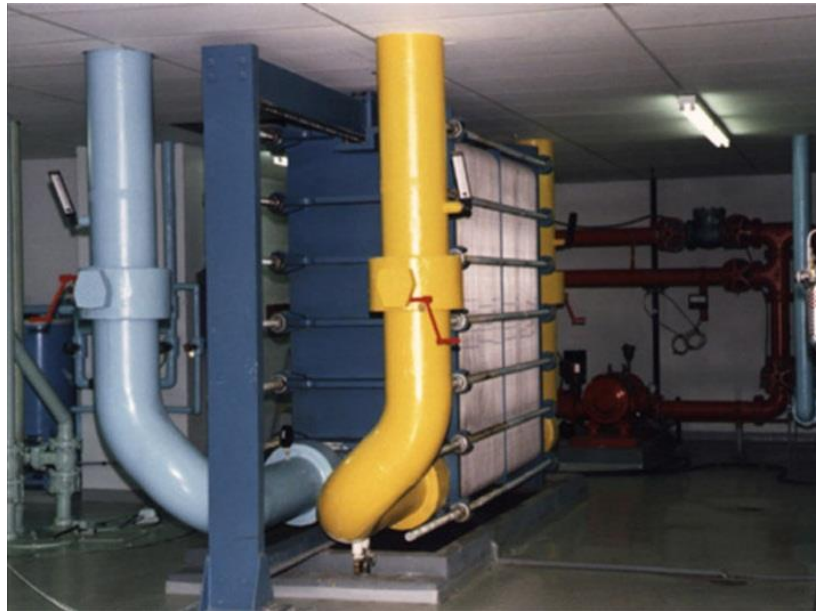
Figura 2.3: Intercambiador de calor de tipo placas
