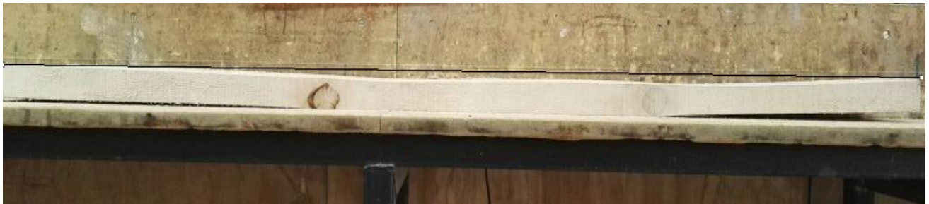
Figura 4.6 Pieza con defecto de arqueradura. Fuente Elaboración propia.
