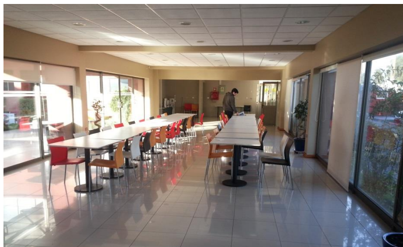
Figura 2. 28 Comedor con losa radiante
