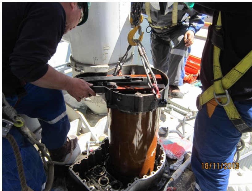
Fig. 30 Elevación selector de carga
