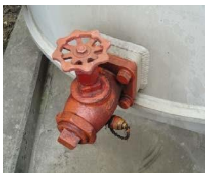
Fig. 21 Válvula de muestreo de aceite.
