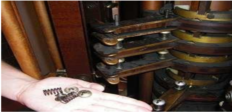
Fig. 34 Muelle de los contactos móviles del selector de carga
