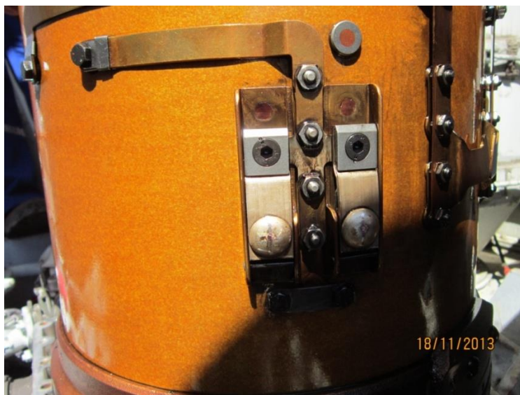
Fig. 33 Contactos del selector de carga
