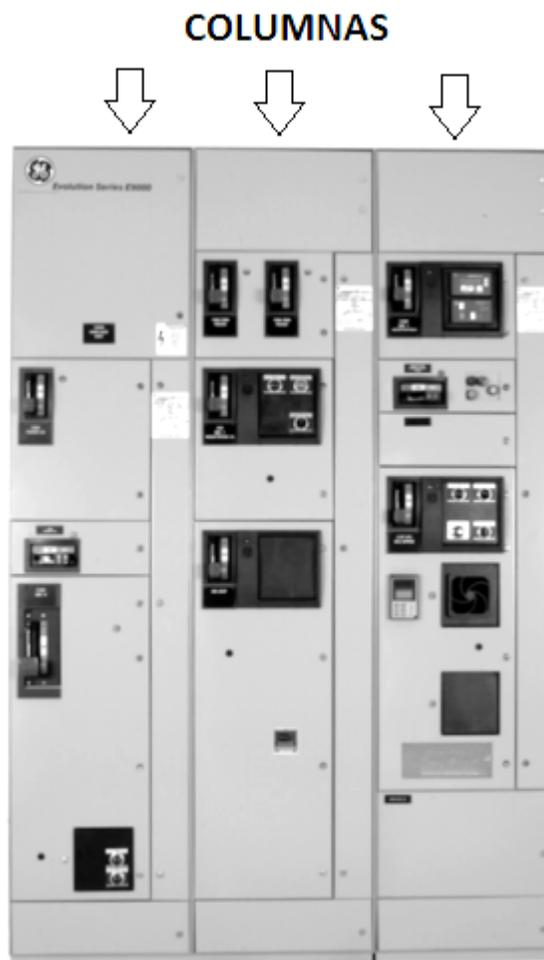
**Figura 2.4: Arreglo de tres columnas Evolution Series GE**
