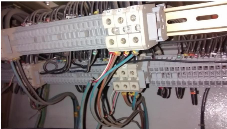
**Figura 1.15: Fotografía que muestra el daño acumulado durante años en bornes de control y potencia**
