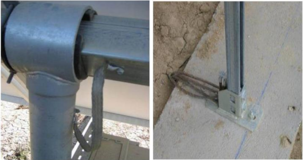
Figura 5.31 Estructura aterrizada.
