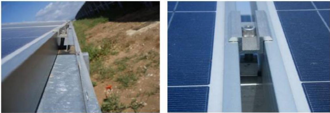
Figura 5.32 Correcto montaje de grapas.
