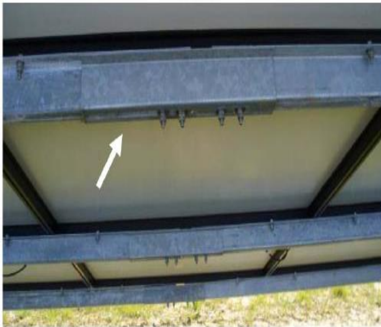
Figura 5.34 Estructura rígida para unión de rieles.
