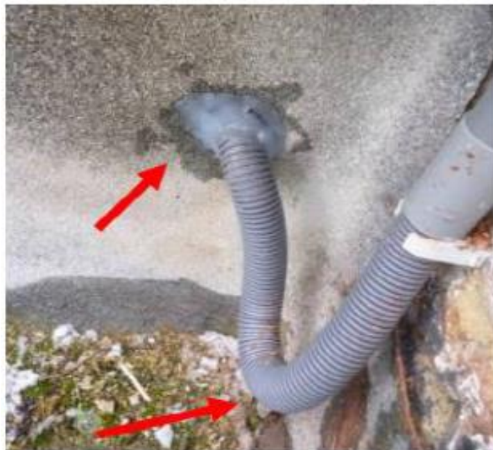
Figura 5.27 Forma correcta de aislar contra humedad.
