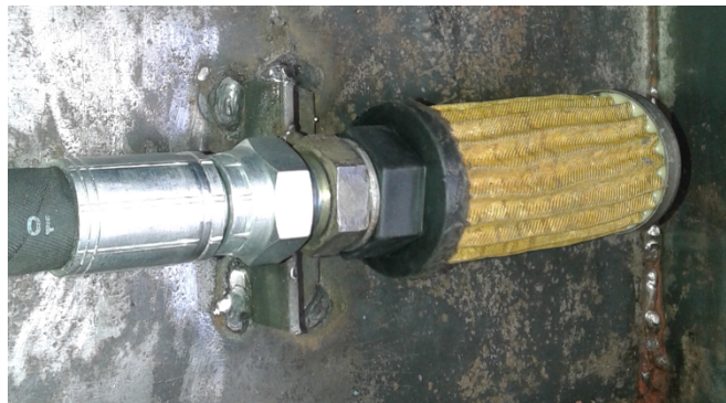
Fig. 3.12 Filtro de succión de malla metálica.
