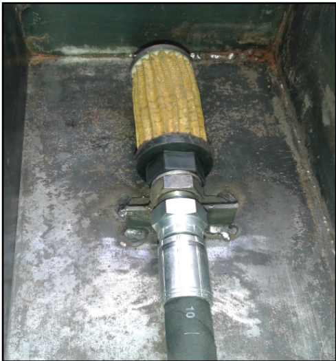
Fig. 1.7 Tanque hidráulico con filtro de succión y soporte.
