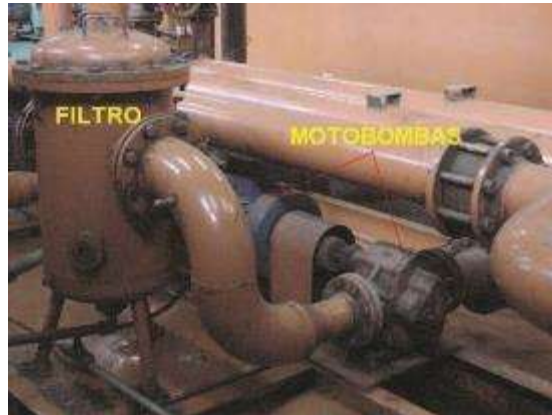
Imagen N° 28: Filtros y motobombas de la central OH4
