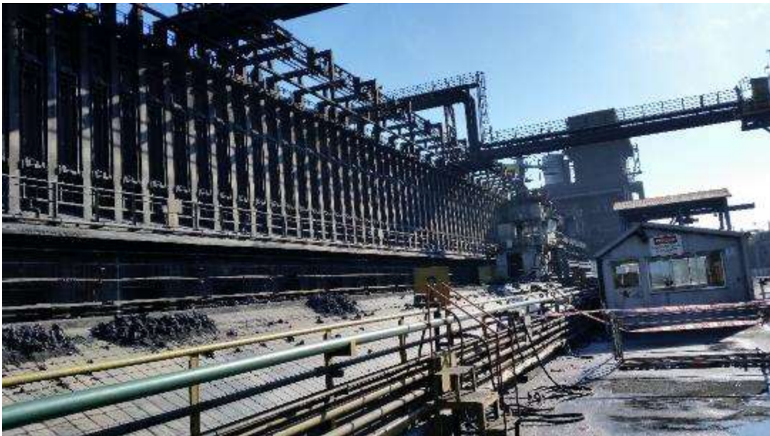
Imagen N° 4: Horno de carbón coque vista desde el lado cerro.
