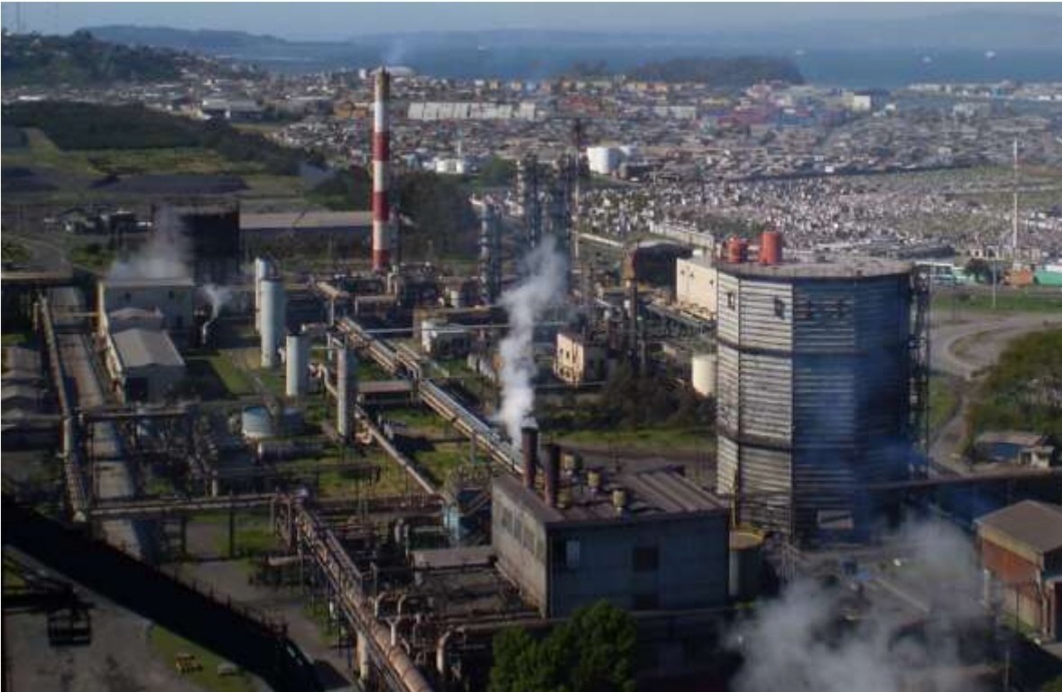
Imagen 6: Extremo norte del área combustibles
