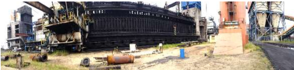
Imagen N° 2: Vista panorámica de las baterías del horno de carbón coque y parte de la planta de coque.
