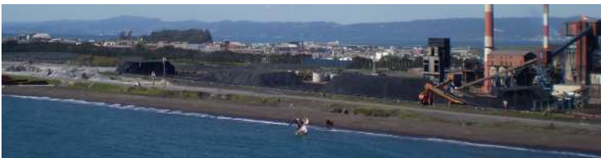
Imagen N°3: Área de almacenamiento del carbón mineral
