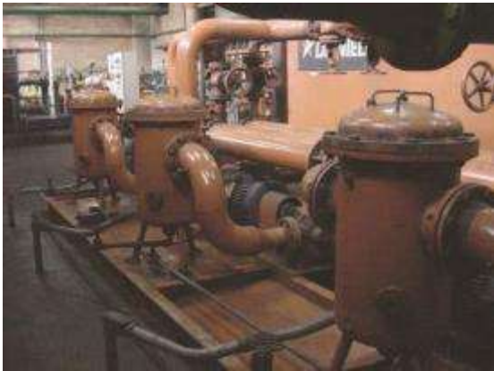
Imagen N° 28: Filtros y motobombas de la central OH4
