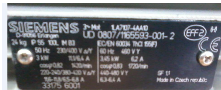
Figura N°28: “Placa características del motor asíncrono”.
