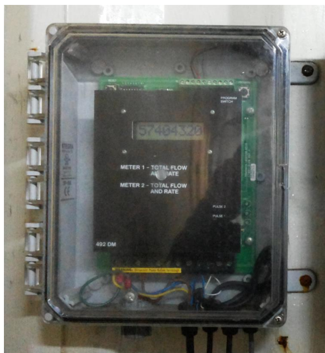
Fig. 2.4. Transmisor de flujo de entrada.
