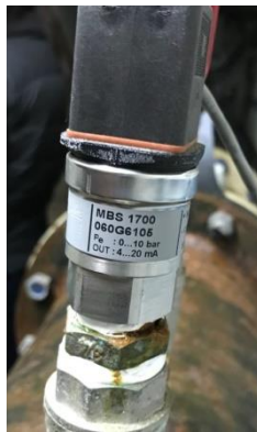
Fig. 6.8. Transmisor de Presión.
