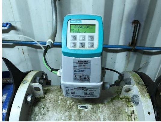
Fig. 6.13. Transmisor de flujo Distribución.
