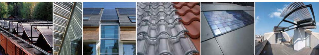
Figura 2.14: Colectores solares térmicos y fotovoltaicos integrados a la arquitectura (Fuente: IEA,2012)
