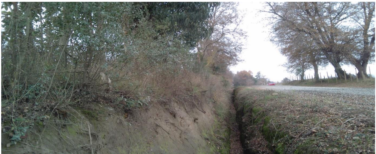
Fotografía A12: Zanja Existente kilómetro 3,1.
