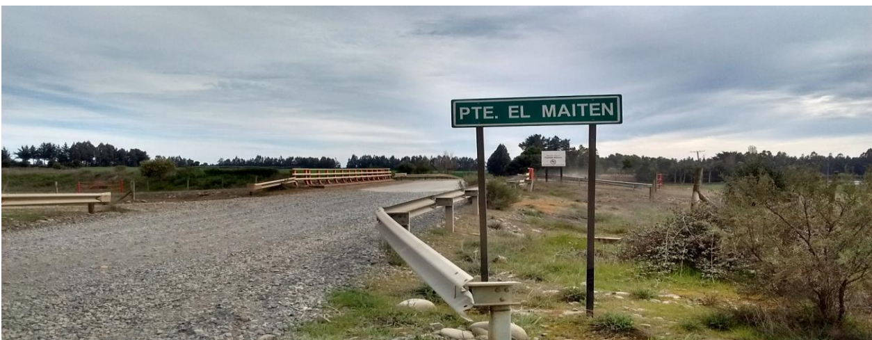
Fotografía A9: Final tramo puente El Maiten con barreras laterales.
