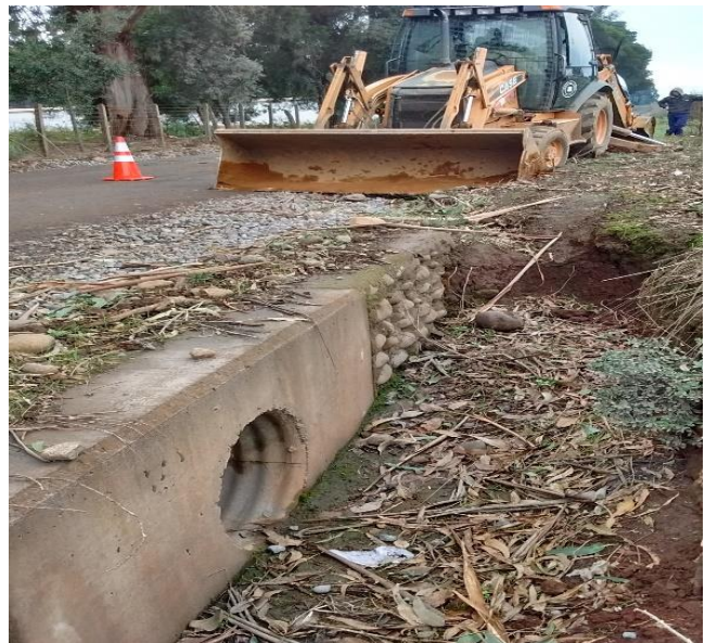
Fotografía A3: Obra de Arte existente km. 0,5.
