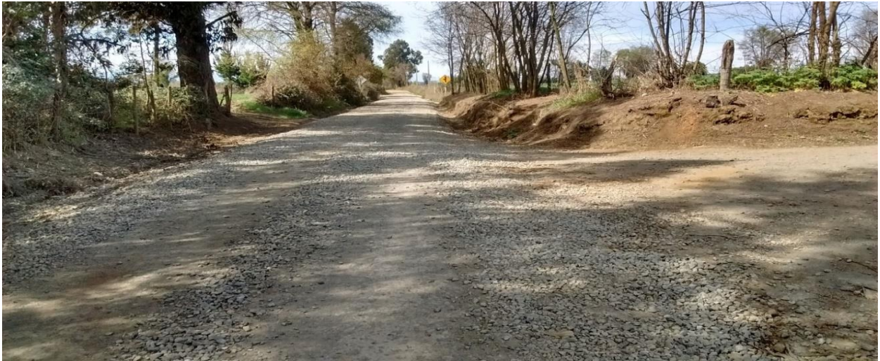
Fotografía A15: Final del tramo proyecto en intersección El Boldo kilómetro 3,37.
