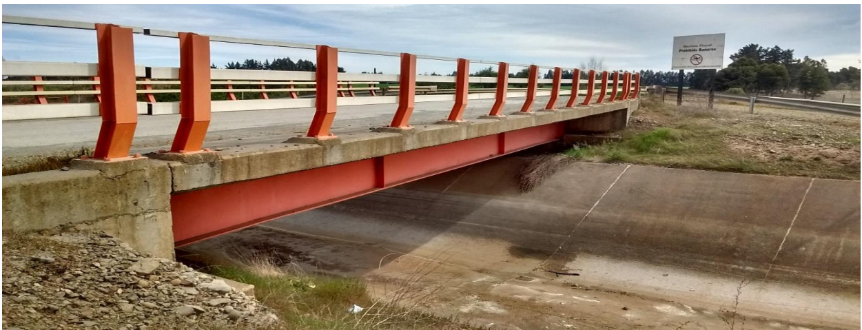
Fotografía A6: Estructura puente El Maiten.
