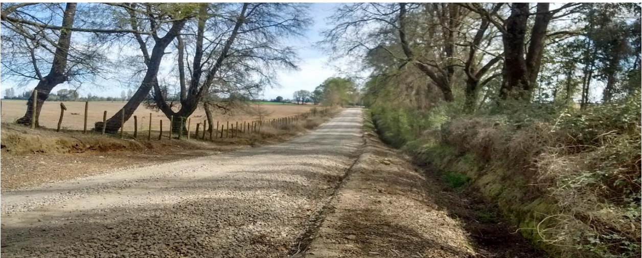
Fotografía A11: Camino Existente kilómetro 3,1.
