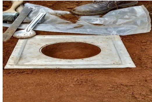
Fotografía B6: Ensayo "Densidad In Situ" C2.
