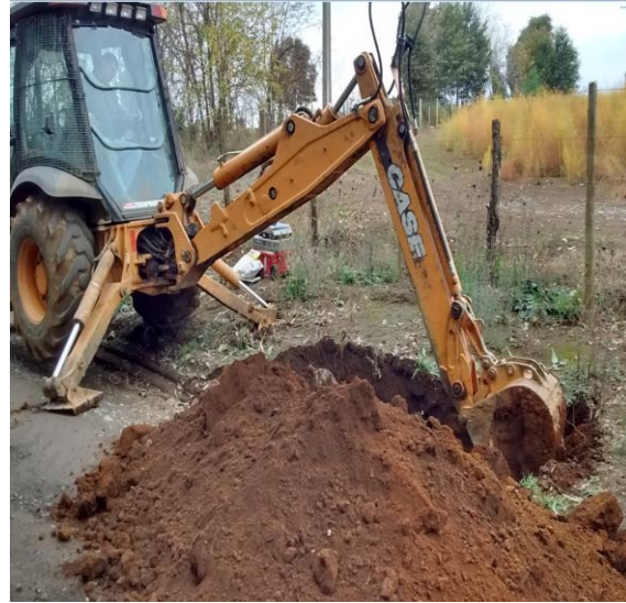
Fotografía B2: Inspección visual Calicata N°2.
