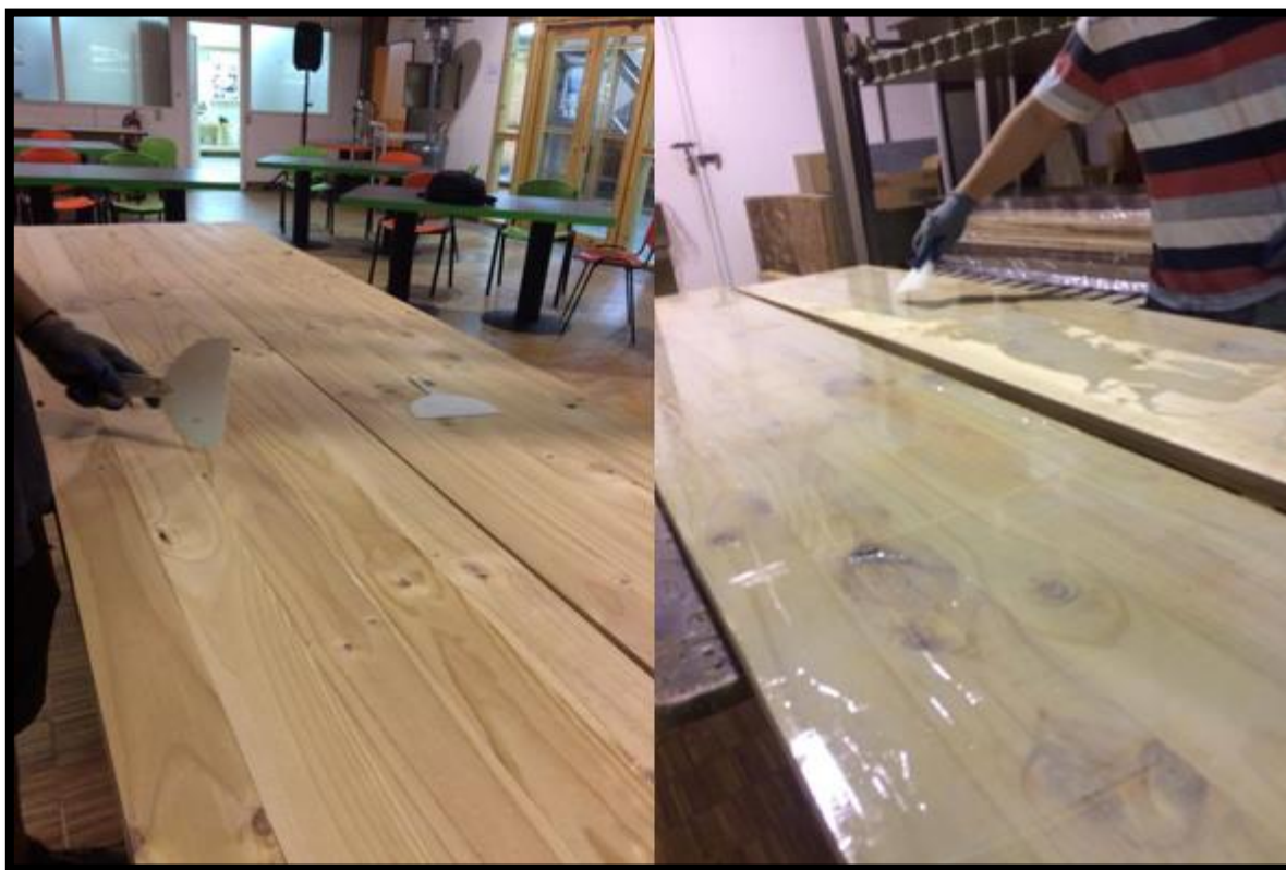
Figura B 2. Inspección y aplicación del adhesivo.
