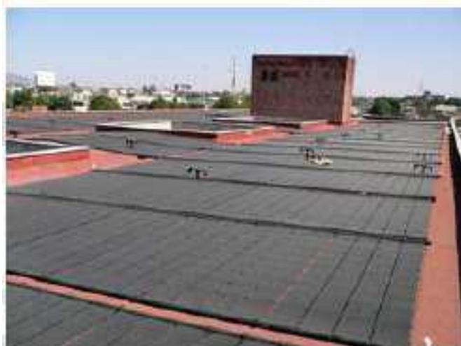
Figura IV\_2.7 Colector solar de placa plana.
