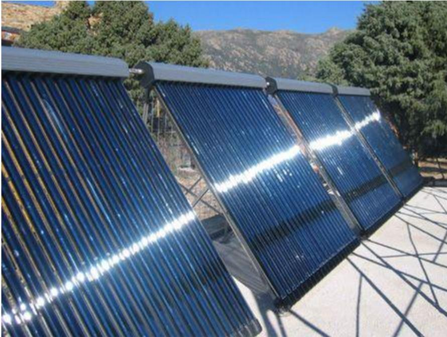
*Figura IV\_2.6 Colector solar tubo de vacío*
