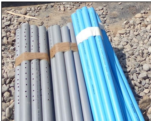
Figura 1A. Tubos PVC antes de ser insertos en el humedal.
