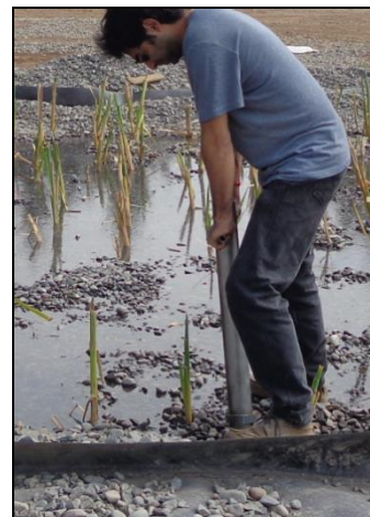
Figura 2A. Detalle de inserción de Tubos PVC en humedal.
