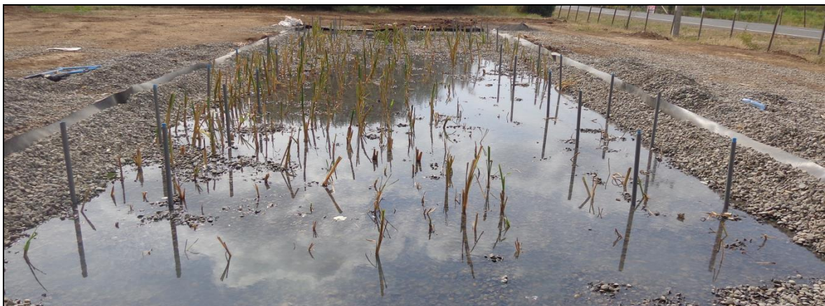
Figura 3A. Tubos instalados en el humedal.
