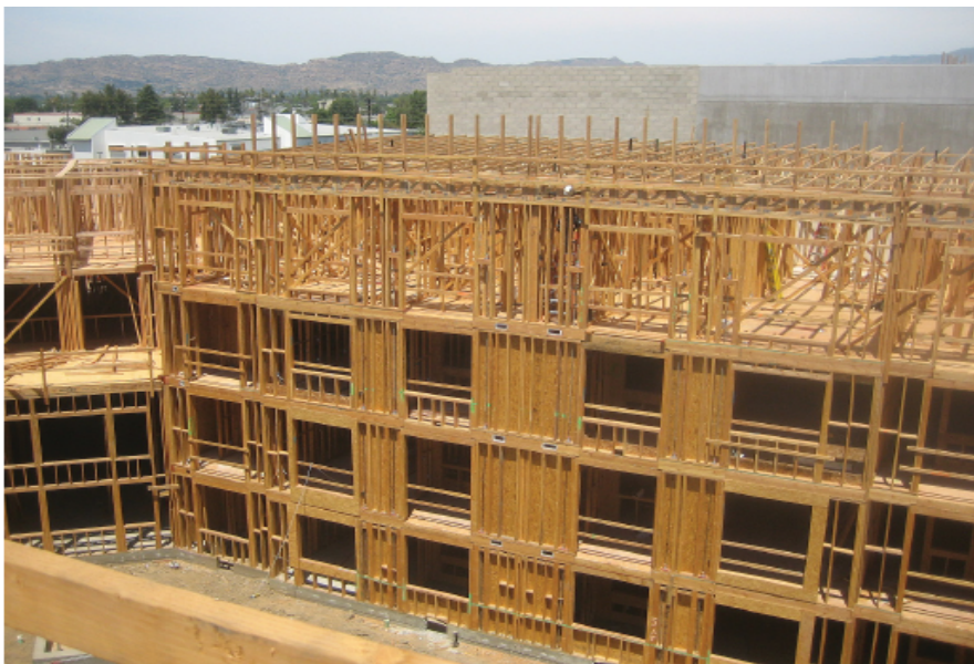
Figura 1. Edificio en construcción según sistema plataforma.
