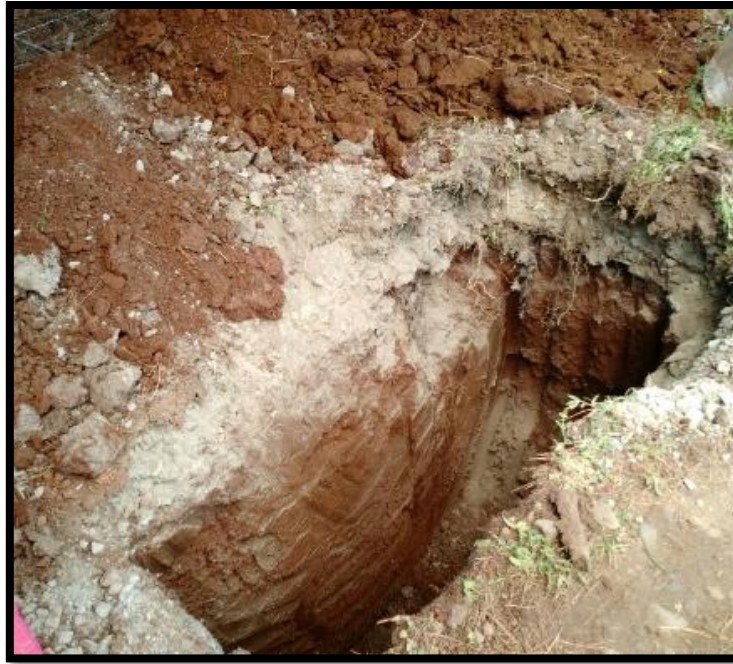
Figura B 5: Calicata 2
