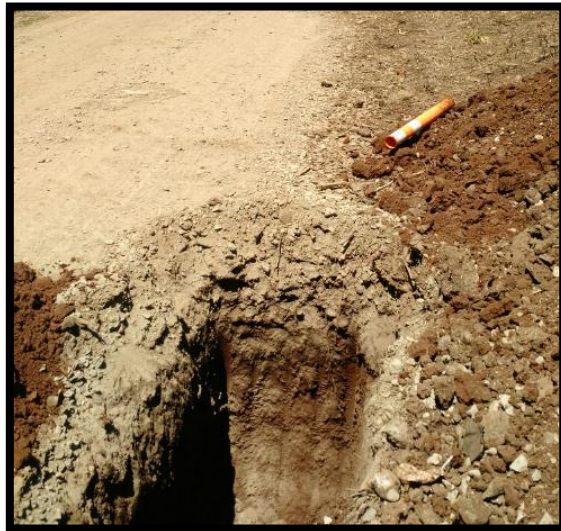
Figura B 2: Calicata 1
