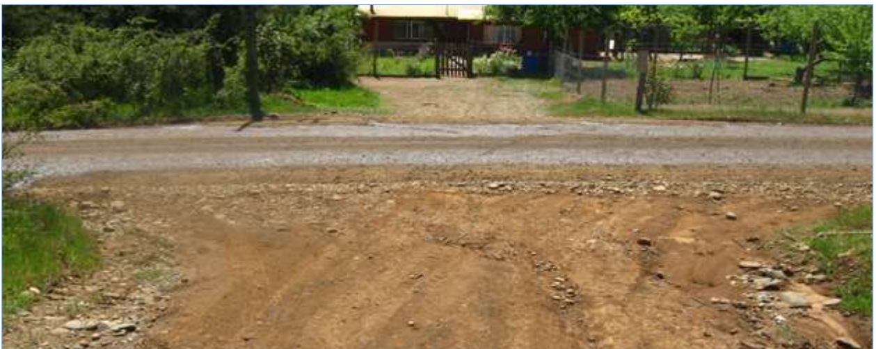
Figura A24: Intersección final, camino El Sótano – Ruta Q-579, km 2,350.
