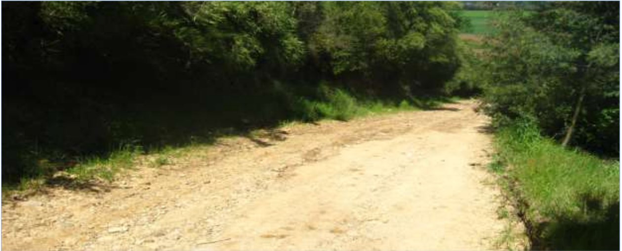
Figura 8C: Tramo en pendiente fuerte.
