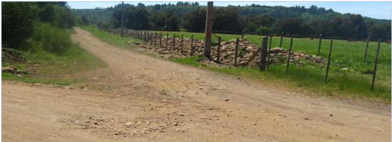
Figura A2: Intersección Camino Las Obras – Camino El Sótano, km 0,000.
