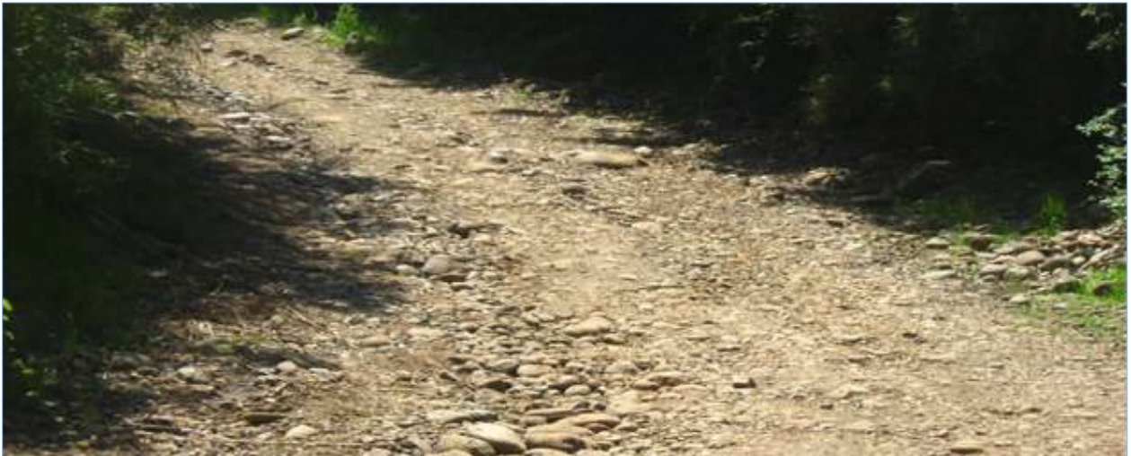
Figura 6C: Sector con superficie de rodado con material sobretamaño.
