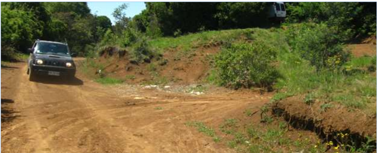
Figura A20: Acceso, km 1,310.
