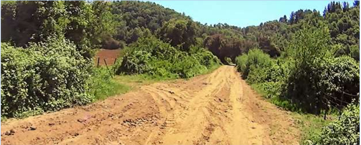
Figura A13: Accesos a predios, km 0,740.
