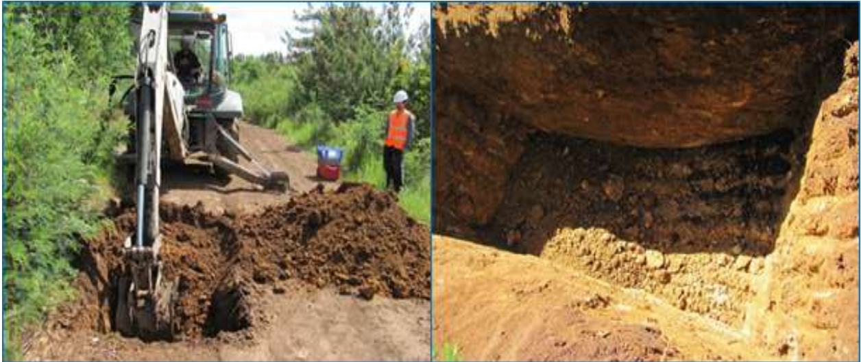
Figura 14: Ejecución de calicata C-2.
