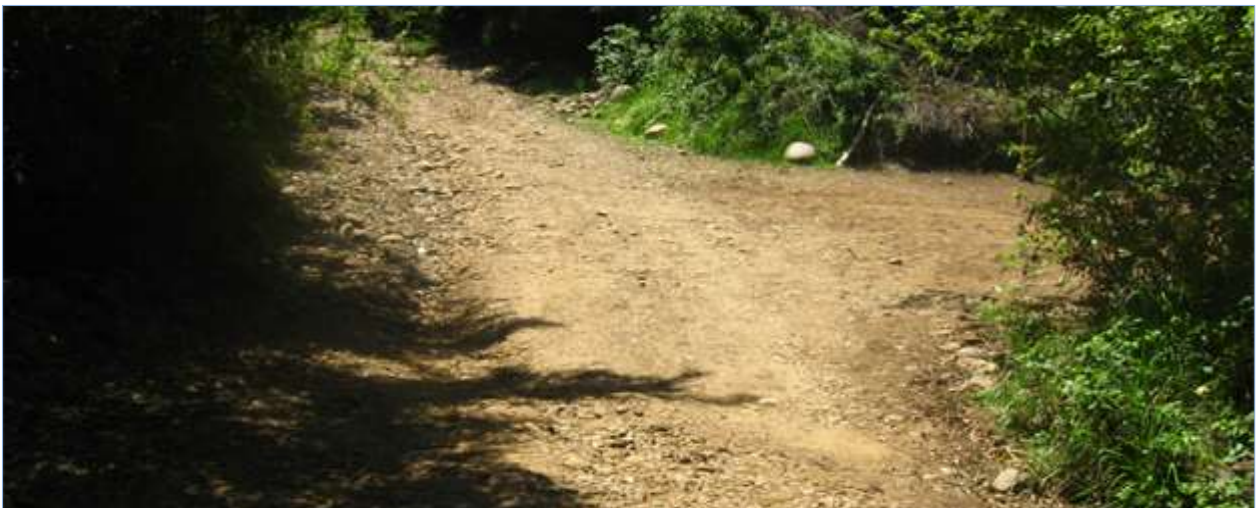
Figura A15: Acceso, km 0,950.
