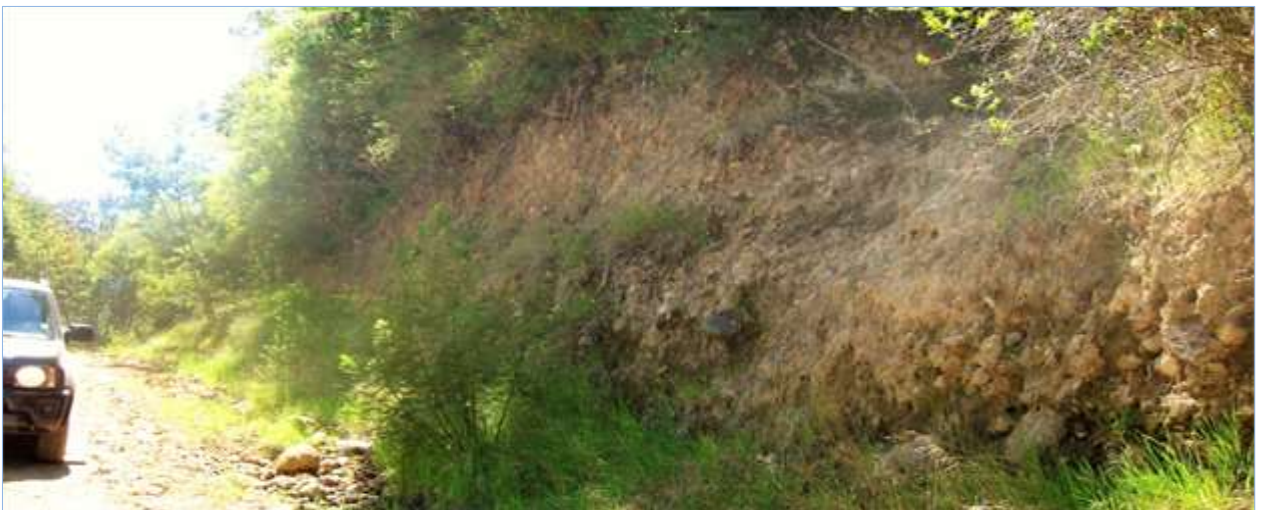
Figura A18: Talud de corte, km 1,110.
