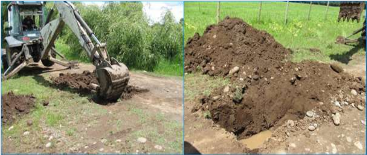
Figura 12: Ejecución de calicata C-1.
