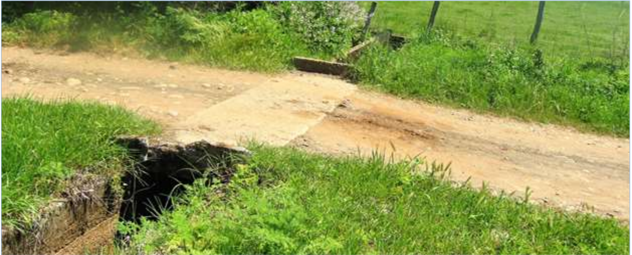
Figura A7: Canal de Riego Revestido, km 0,180.
