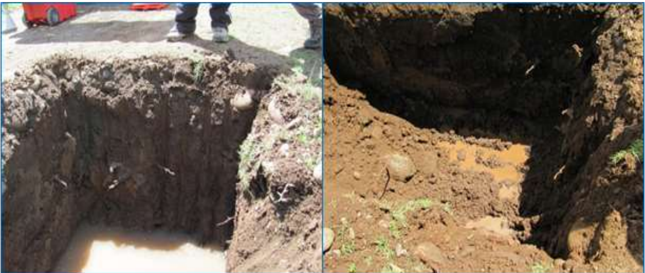
Figura 13: Presencia de napa freática en calicata C-1.
