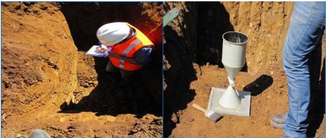
Figura 15: Realización de descripción visual y Densidad in situ en calicata C-2.
