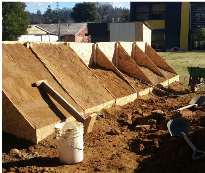
Figura D1: Construcción de lisímetros. (Fuente: Elaboración propia)
