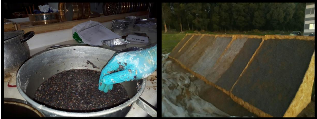
Figura 7. Procedimiento de mezcla de hidrosiembra.
