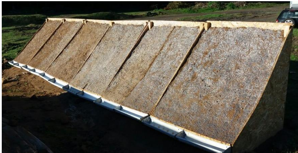
Figura D4: Hidrosiembra aplicada (Fuente: Elaboración propia)
