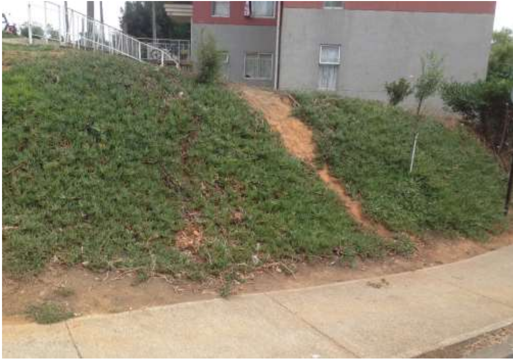
Efecto del pisoteo en taludes urbanos de otros sectores de Penco con doca como recubrimiento vegetal, Fuente: Elaboración propia (2017). (20)
