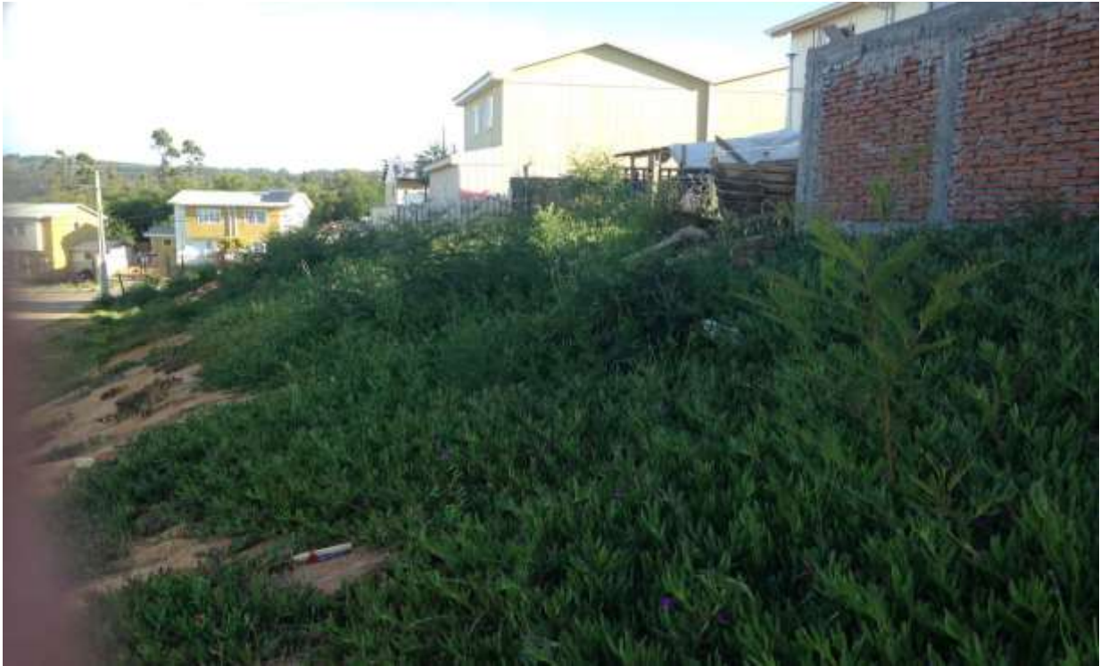
Talud PMP, Corona del Talud. Elaboración Propia (2016).(6)
