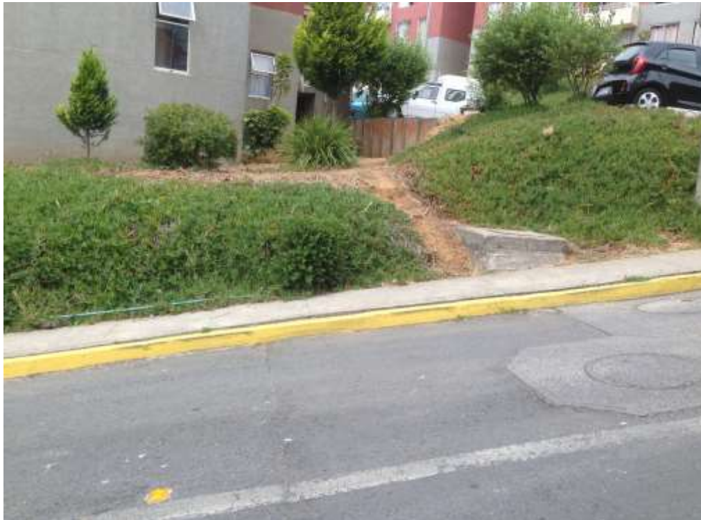
Efecto del pisoteo en taludes urbanos de otros sectores de Penco con doca como recubrimiento vegetal, Fuente: Elaboración propia (2017). (21)
