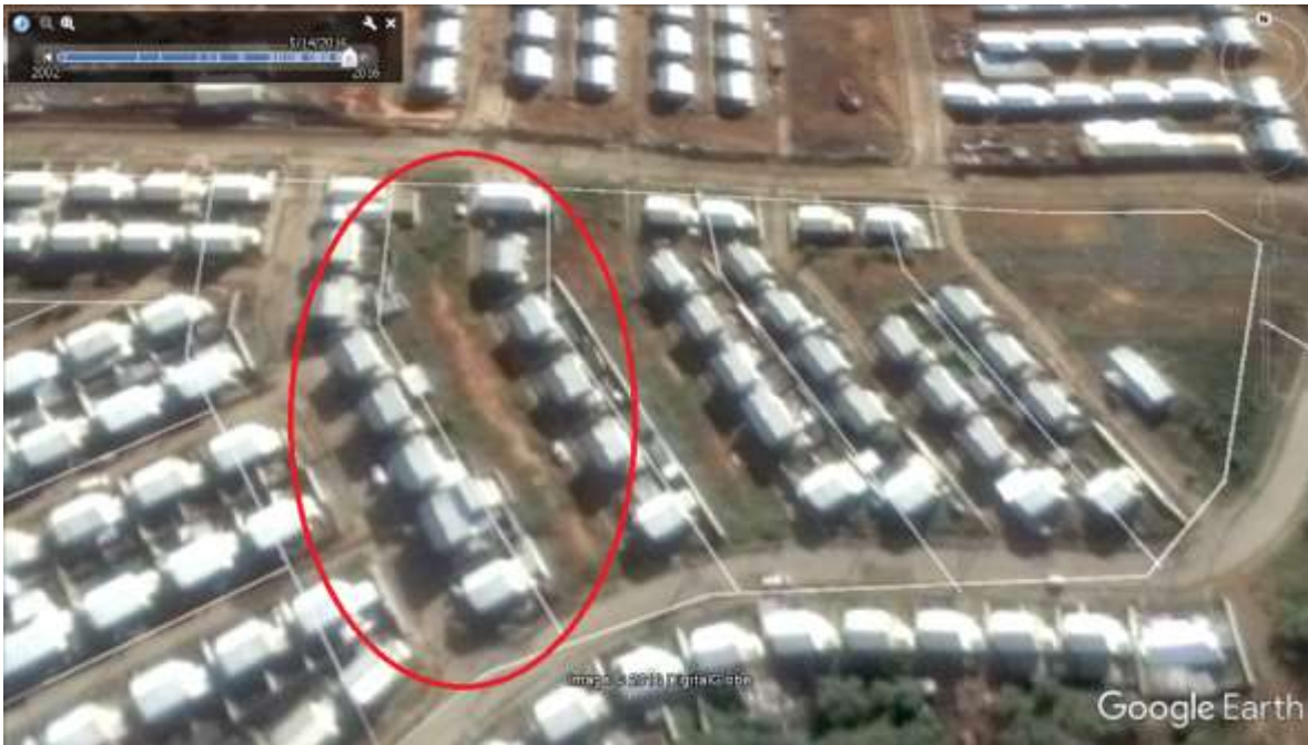
Talud PMP, 14 de mayo de 2016, Fuente Google Earth (2016). (16)
