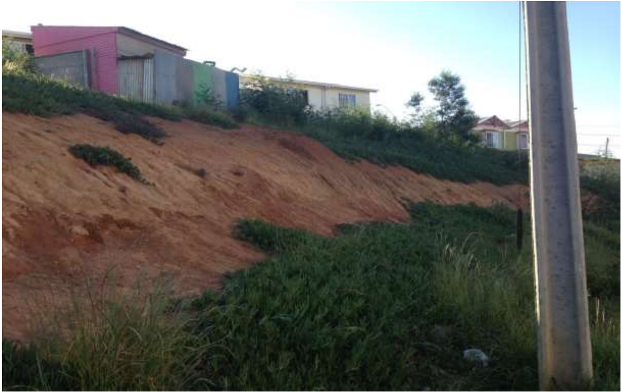
Talud PMP, Zona con Mayor Pendiente., Fuente Elaboración Propia (2016).(2)
