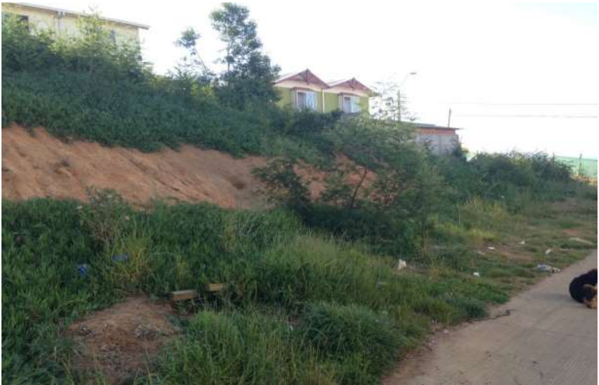
Talud PMP, Cara del Talud Con Mayor Vegetación, Elaboración Propia (2016).(7)
