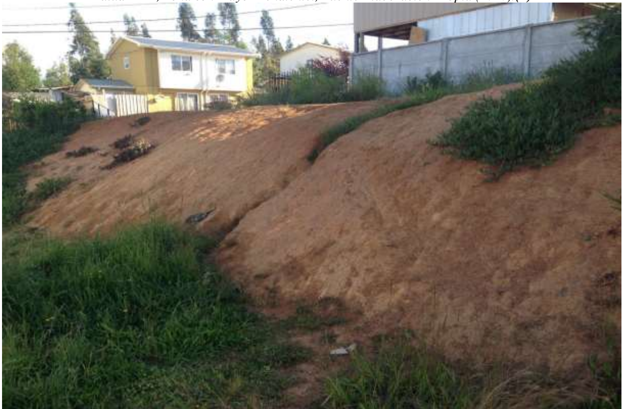
Talud PMP, Zona con Menor Altura, al comienzo del talud., Elaboración Propia (2016).(3)
