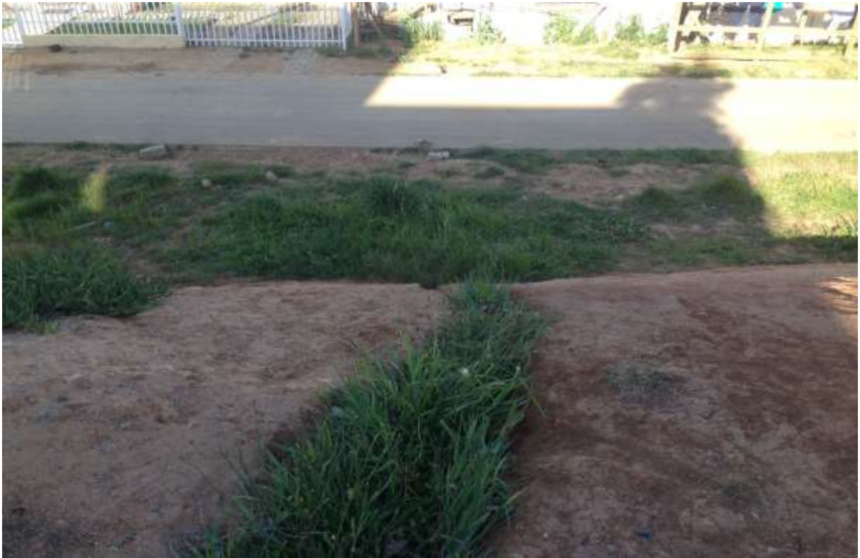
Talud PMP, Pie del Talud, Elaboración Propia (2016). (5)
