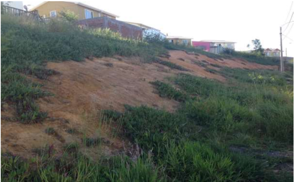
Talud PMP, Zona Con Menor Pendiente., Fuente Elaboración Propia (2016).(1)
