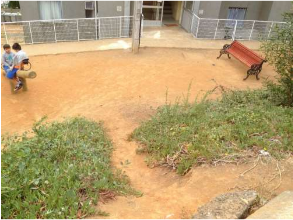
Efecto del pisoteo en taludes urbanos de otros sectores de Penco con doca como recubrimiento vegetal, Fuente: Elaboración propia (2017). (22)
