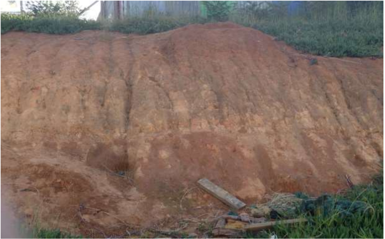
Talud PMP, Surquillos, Elaboración Propia (2016). (10)
