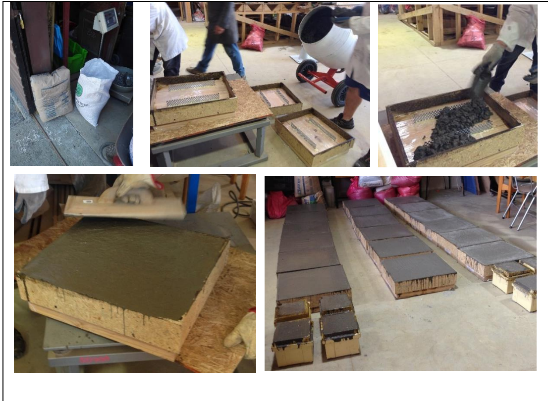
Figura D7. Proceso de hormigonado.
