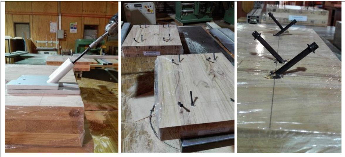
Figura D6. Inserción de conectores SFS.
