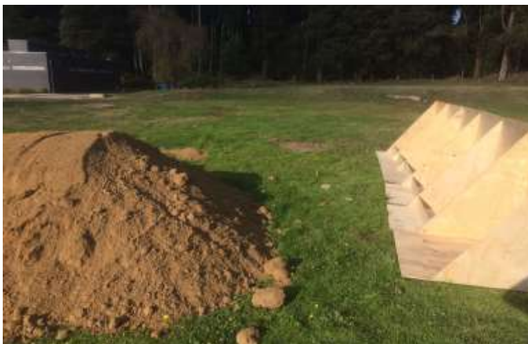
Figura 6. Construcción de lisímetros. (Fuente: Elaboración propia)
