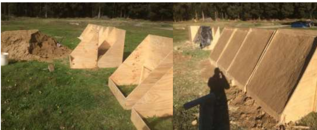
Figura 7. Construcción de lisímetros. (Fuente: Elaboración propia)
