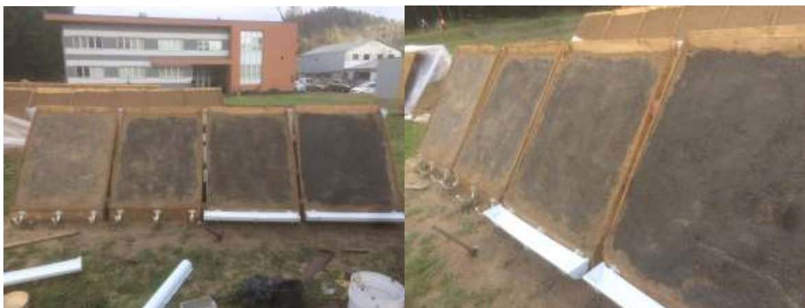
Figura 11. Hidrosiembra y Sistema de recolección de flujo superficial (Fuente: Elaboración propia)
