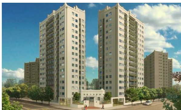
Figura N° 2. Edificio Plaza Mayor IV, Concepción Centro
