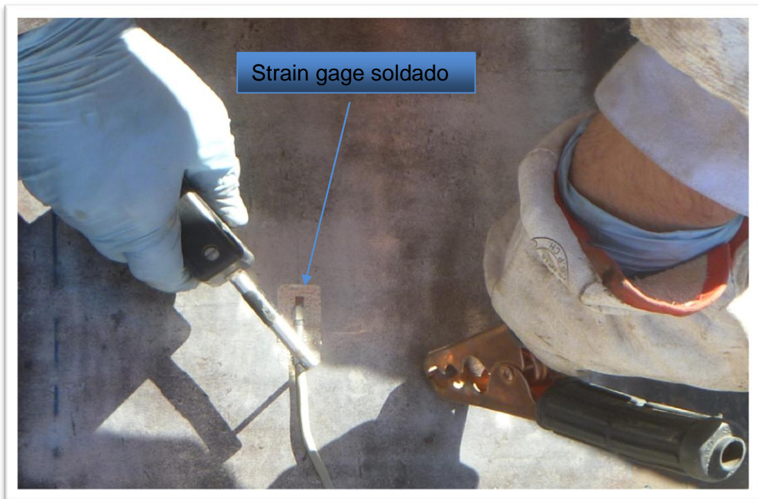
Figura 7.2.4i. Soldadura en terreno con máquina Kyowa.
