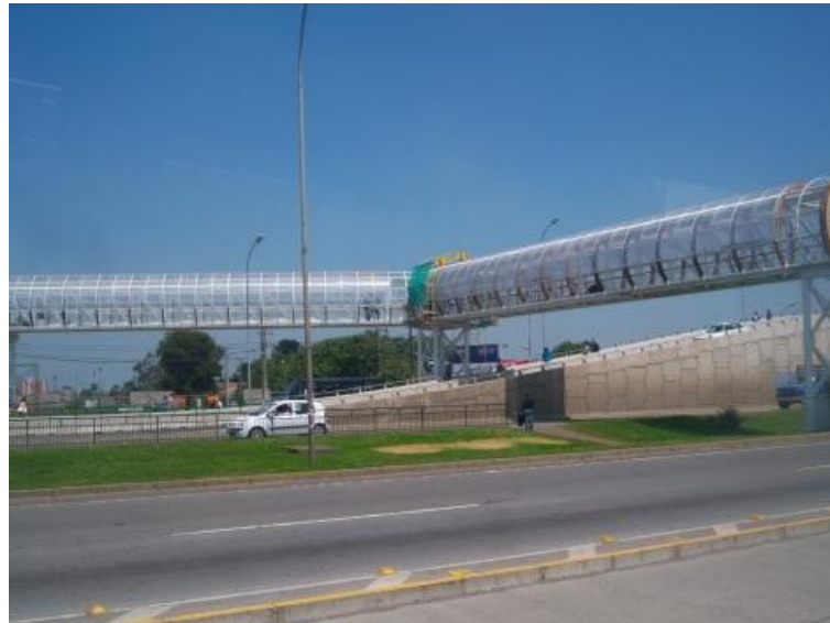
Figura 4 Pasarela Mall Plaza del Trébol.
