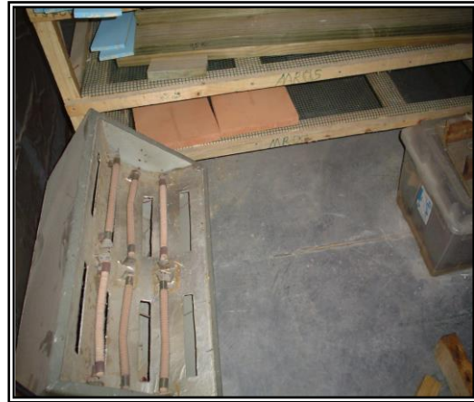
Foto N°32: Interior de la cámara, donde se aprecia el calefactor.
