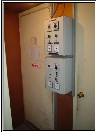
Foto N°31: Cámara de climatización .
