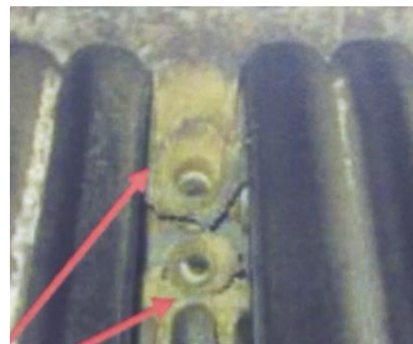
Figura 8. Tubos de la pared derecha cortados.
