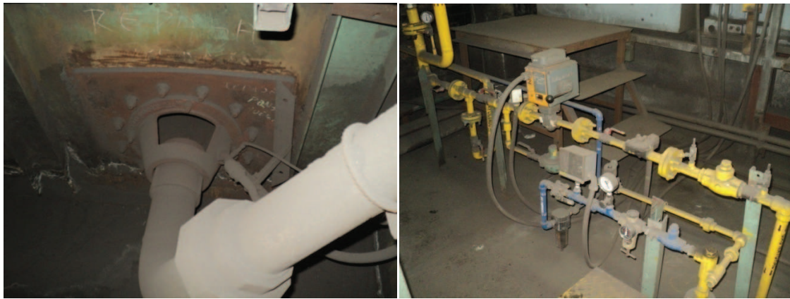
Fig.4.17 Quemador y tren de GN LF5.
