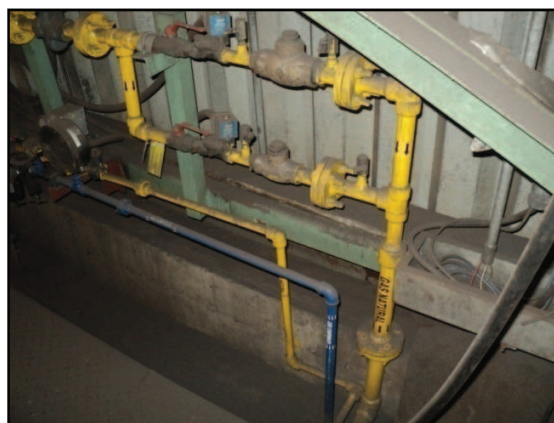
Fig. 4.16 Tren paralelo para dos combustibles.
